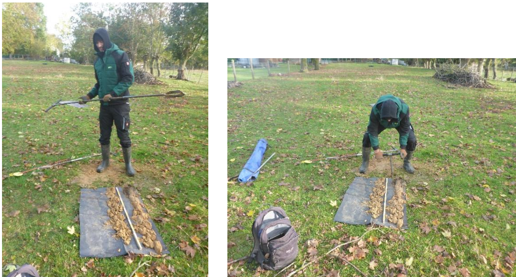
Figuur 44. uitvoering van Boring B5
