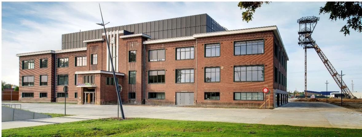
Figuur 23: Voorzijde van het hoofdgebouw met op de achtergrond de noordelijke schachtblok. (©Greenville)
