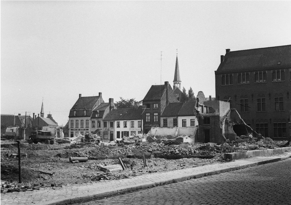
Figuur 18: Zicht op de sloop van het Stedelijk slachthuis. Foto getrokken vanuit de Maagdenstraat, 1956 (bron: Beeldbank Brugge, inv.BRU001022539)
