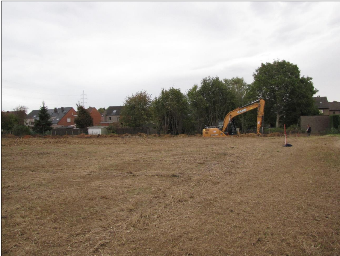
Figuur 8 Overzicht van de aanleg van proefsleuf 2 in het lager gelegen deel van het terrein. Een duidelijk niveauverschil kan worden opgemerkt.
