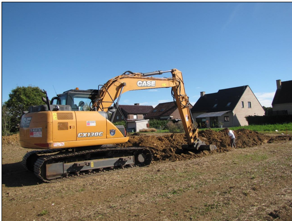
Figuur 5 Foto van de aanleg van de proefsleuf 3.
