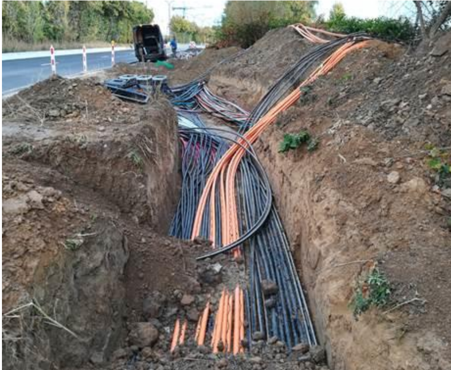
Foto 4 : Het terrein ter hoogte van boorpunt 1 met de nieuw aangelegde leidingen (©Geosonda)
