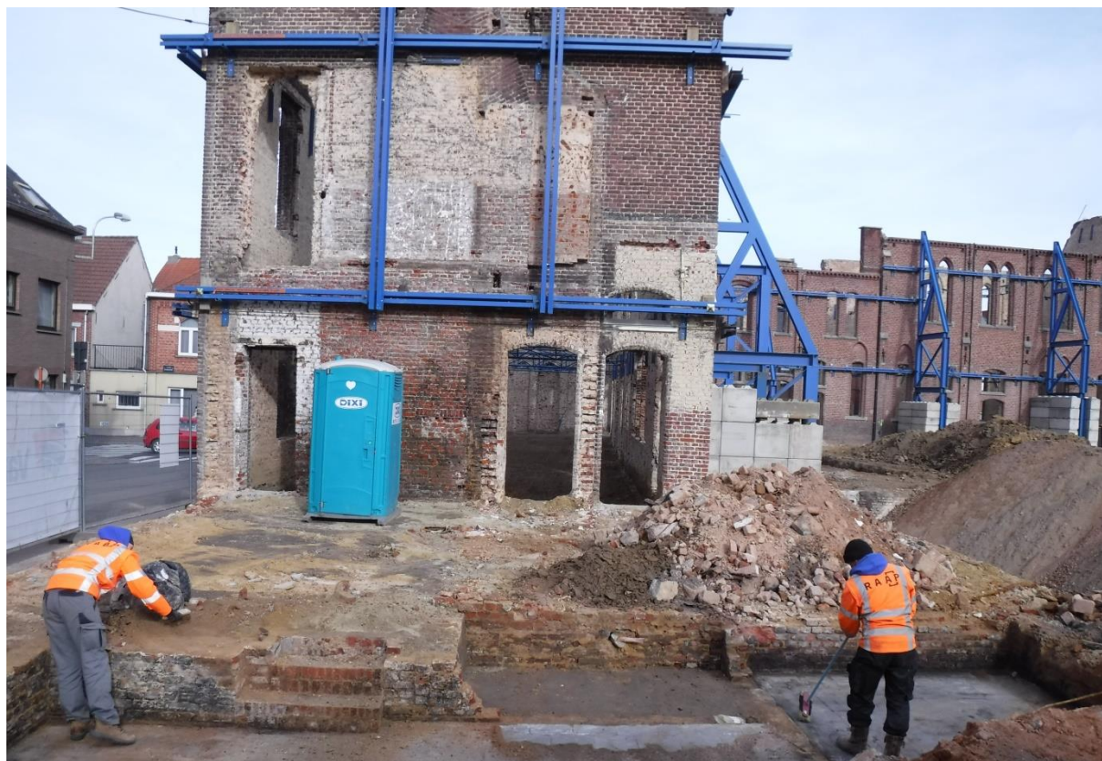
figuur 2 terreinsituatie langs de kasteelstraat. Rechts achter zijn de grote schoren op steunblokken zichtbaar.
