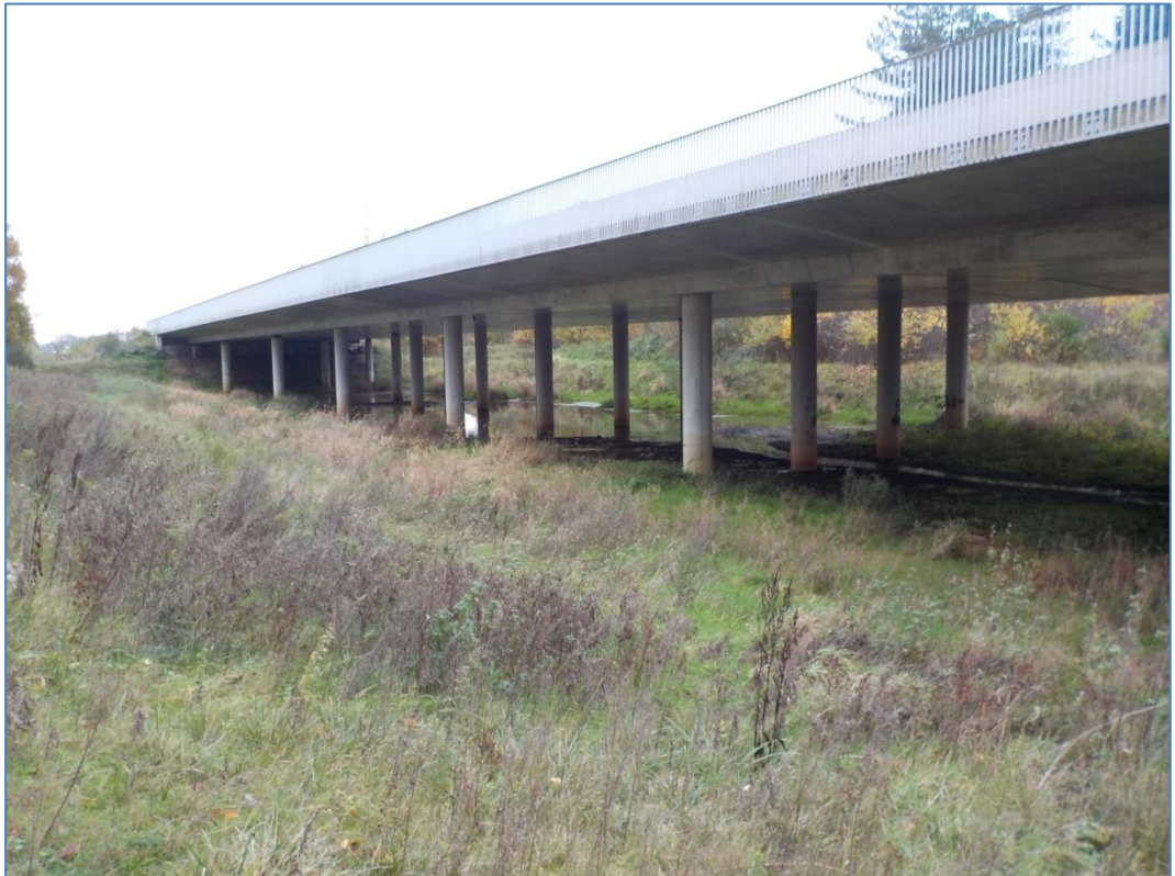
Afb. 8. Overzicht van de 2 – 3 m diepe uitgraving binnen het plangebied onder het recente viaduct van de N19g (15-11-2017). De foto is in zuidwestelijke richting genomen.
