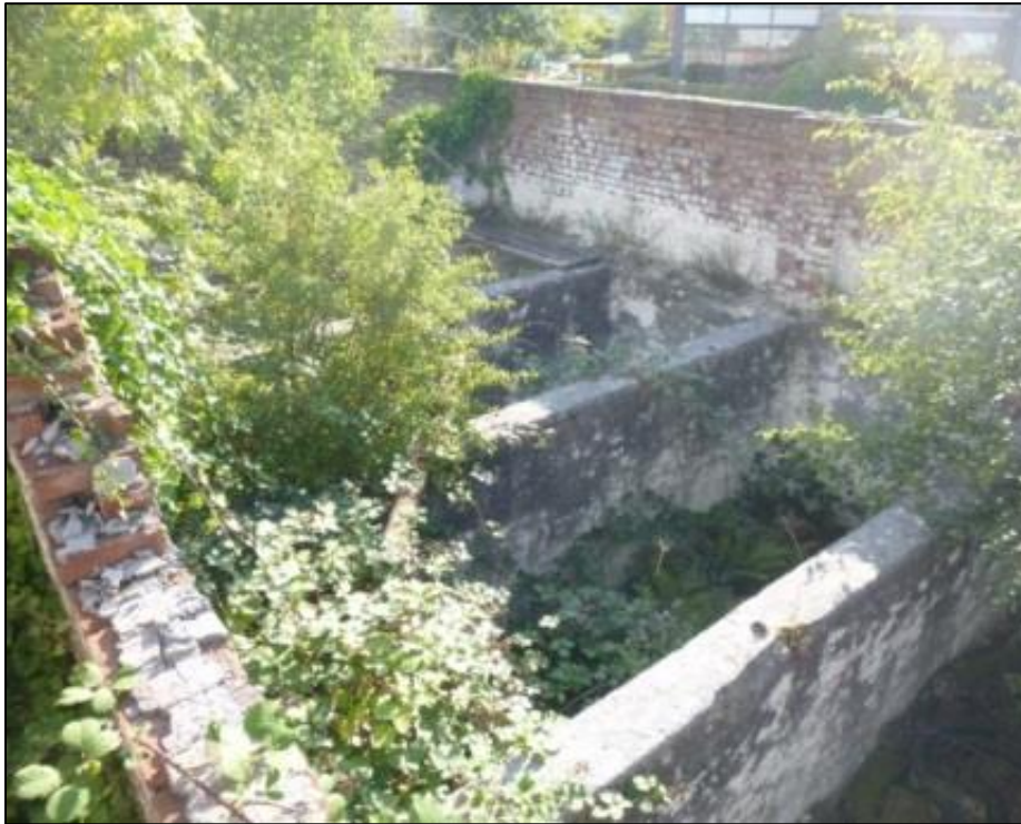
Afb. 5: Foto van de kalkkuilen in het noordwesten van het terrein (Bron: Origin, dd onbekend, 2018G214)
