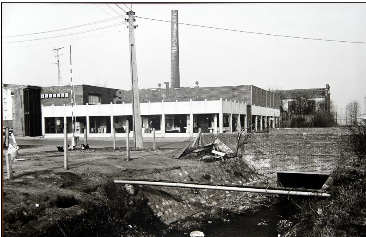
Afb. 26: Foto genomen omstreeks 1980 van de nog niet overwelfde Demer ten zuiden van het huidige onderzoeksterrein, met op de achtergrond de verlaagde schoorsteen van de gelatinefabriek (Bron; Stadsarchief Hasselt, dd onbekend, 2018G214)
