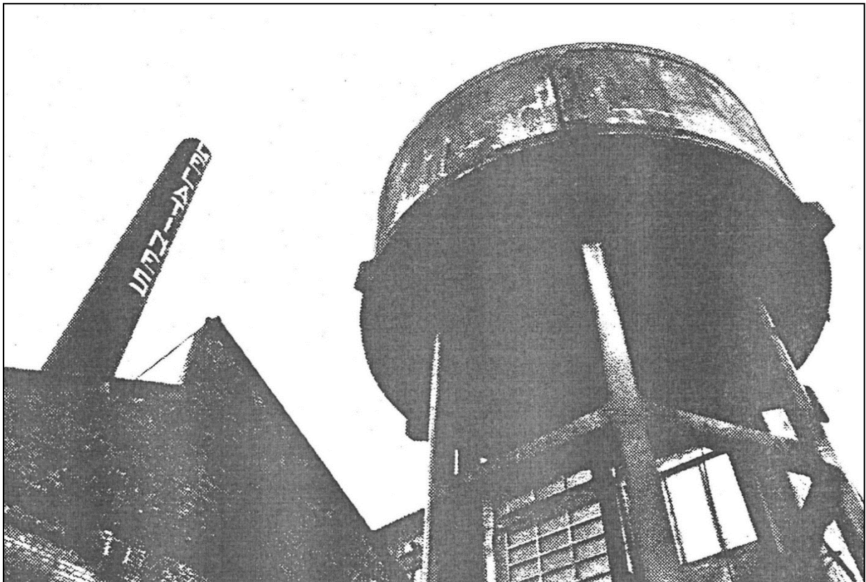
Afb. 29: Foto van de betonnen watertoren op de gelatinesite (Bron: J. Ools, Industriële renovaties de gélatinefabriek van Hasselt, 1984, dd onbekend, 2018G214).
