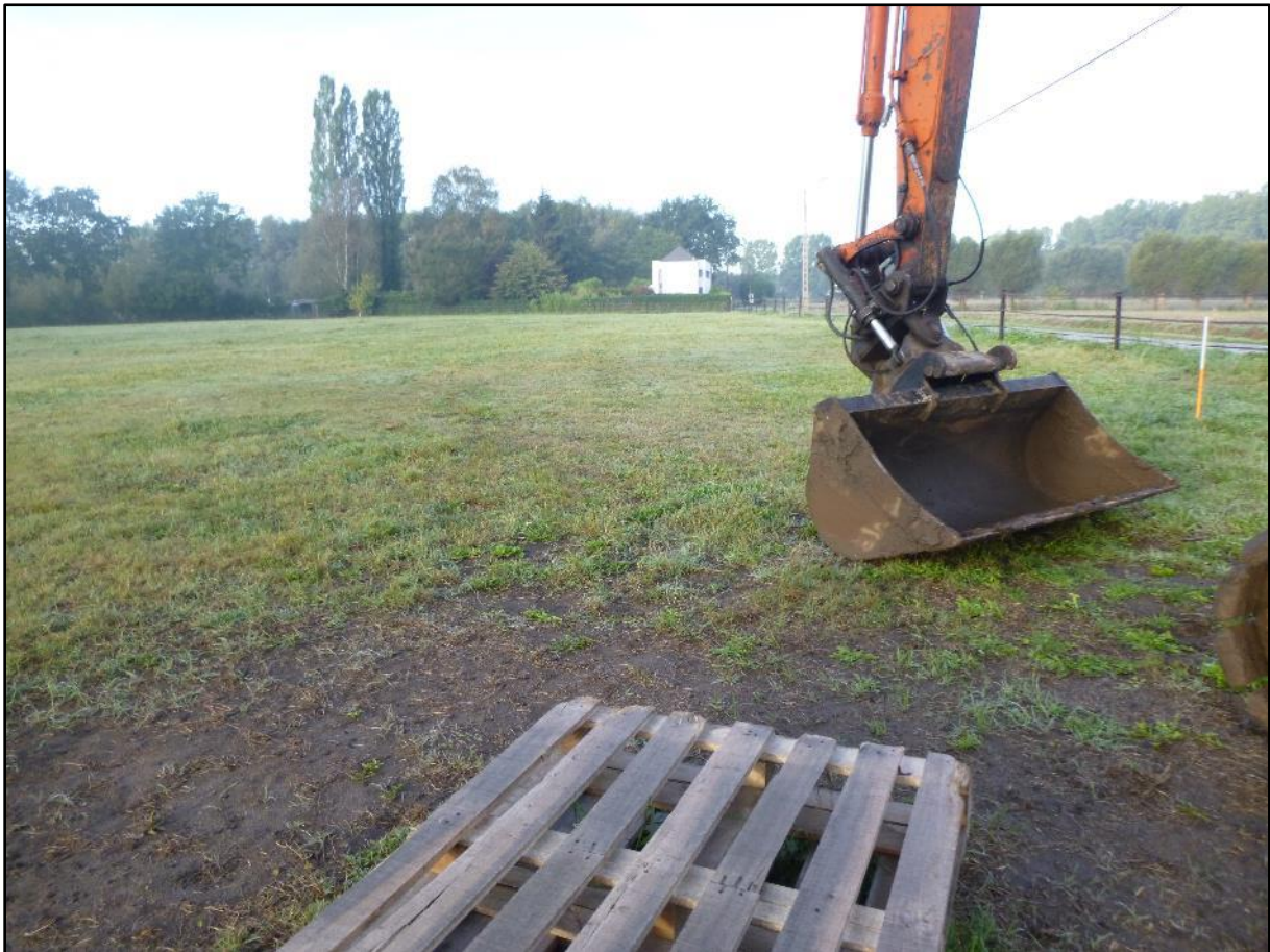
Figuur 15: Het terrein voor grondverbetering gezien vanuit het zuiden voorafgaand de start van het onderzoek (ABO nv 2018)
