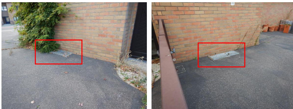
Fig. 8: lucht- en lichtgaten van de kelder onder het pand op perceel A394z
