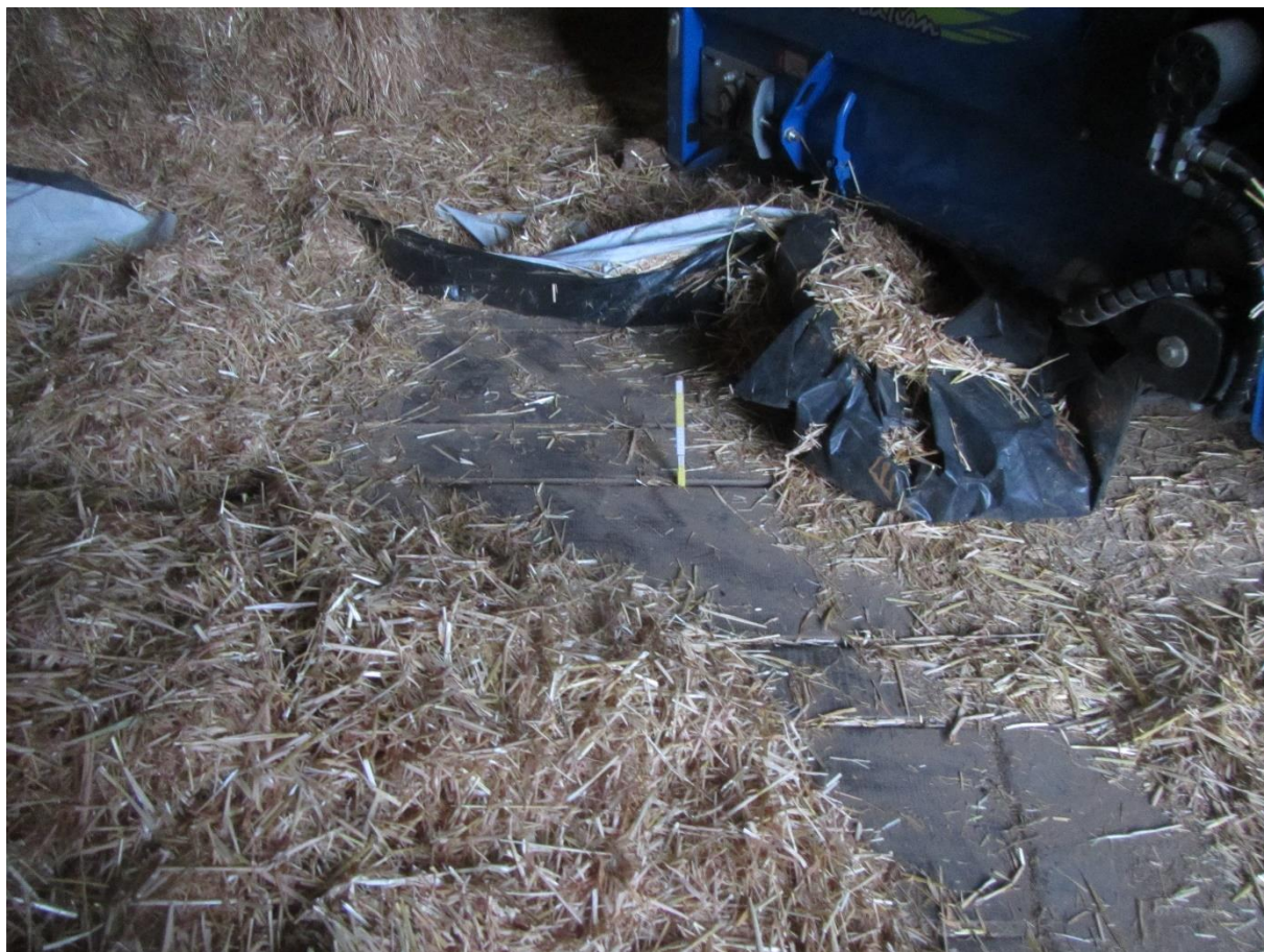
Figuur 11: Een van de luchtkanalen in de schuur die dienstdeden als drooggang voor de opslag van aardappelen en ajuinen. Deze gangen waren 1m breed, de tussenruimte was eveneens 1m.
