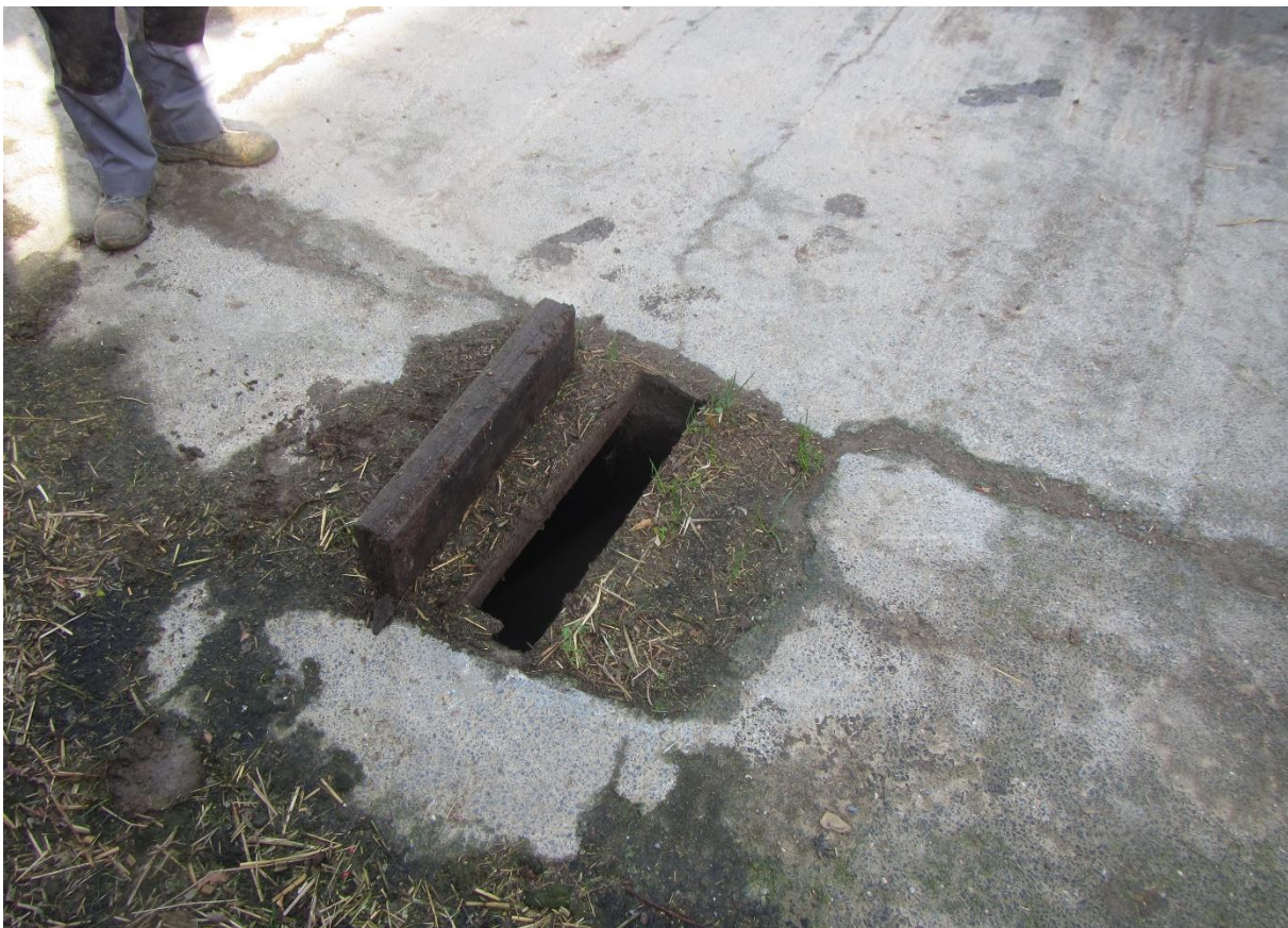
Figuur 10: Mangat met toegang tot één van de vier ondergrondse aalputten (nummer 3 op figuur 6).
