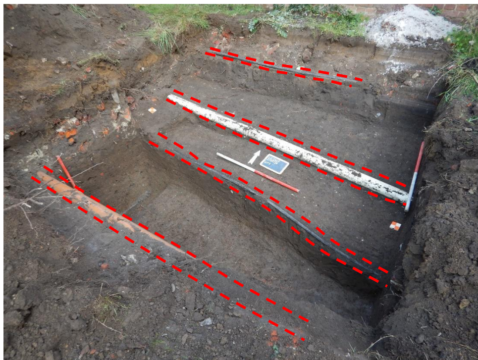
Figuur 13: Zicht vanuit het zuiden op de aangelegde WP 4 met twee waterleidingen en twee elektriciteitskabels.
