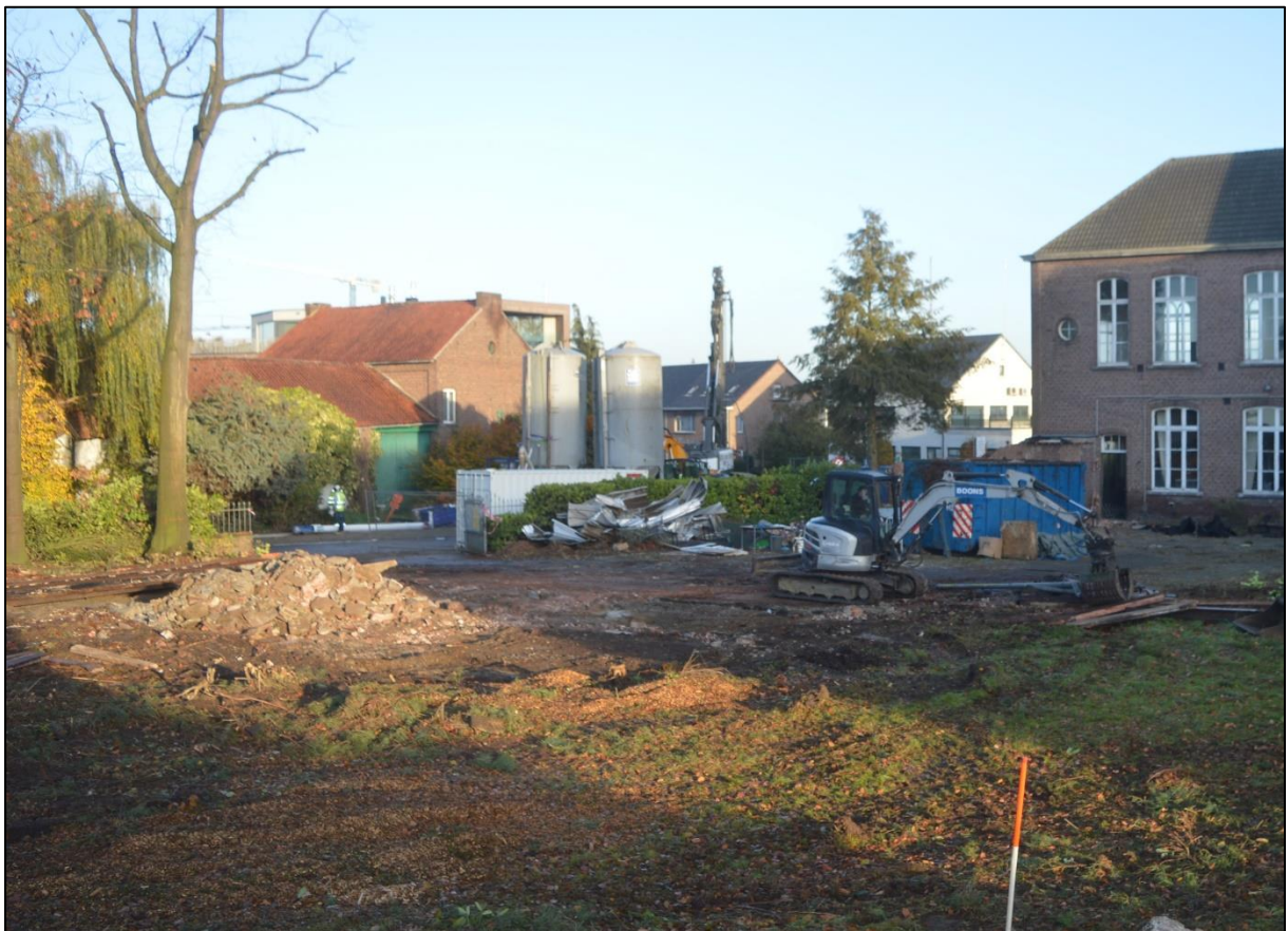
Afb. 17: Zicht op het puin van de renovatiewerken in het noordwestelijke deel van het onderzoeksterrein (Bron: Aron bvba, dd. 08/11/2018, 2018K65).
