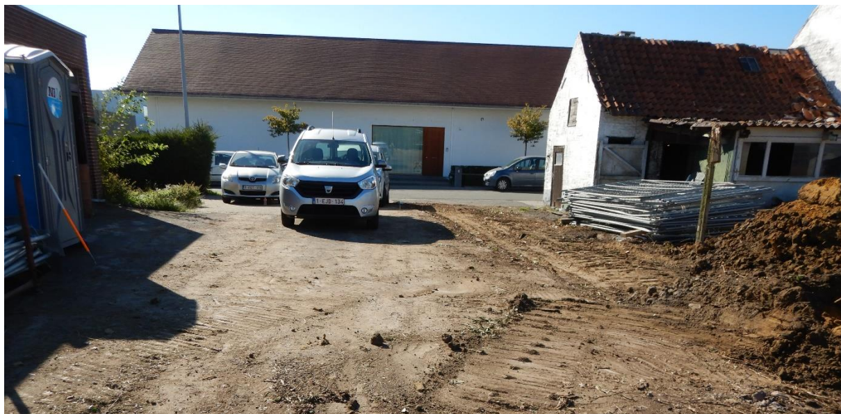
Figuur 7: Verharde oprit (B)
