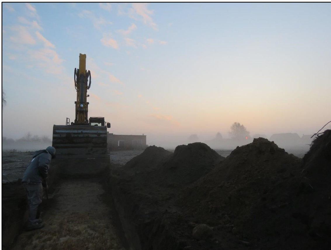
Figuur 7 Sfeerbeeld tijdens de aanleg van sleuf 1.
