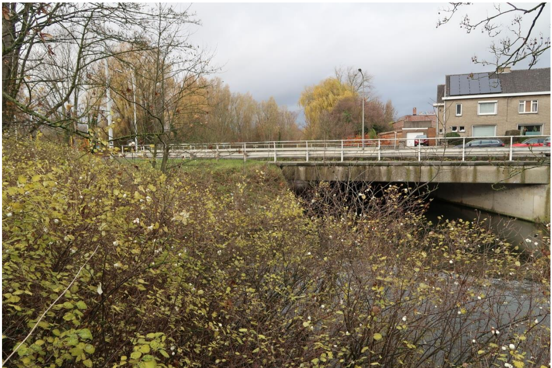
Foto 3: Zicht vanop het bestaande fietspad van het Alice Béviairepad op de bestaande koker (Stad Gent, De Zwarte Doos, Stadsarcheologie)
