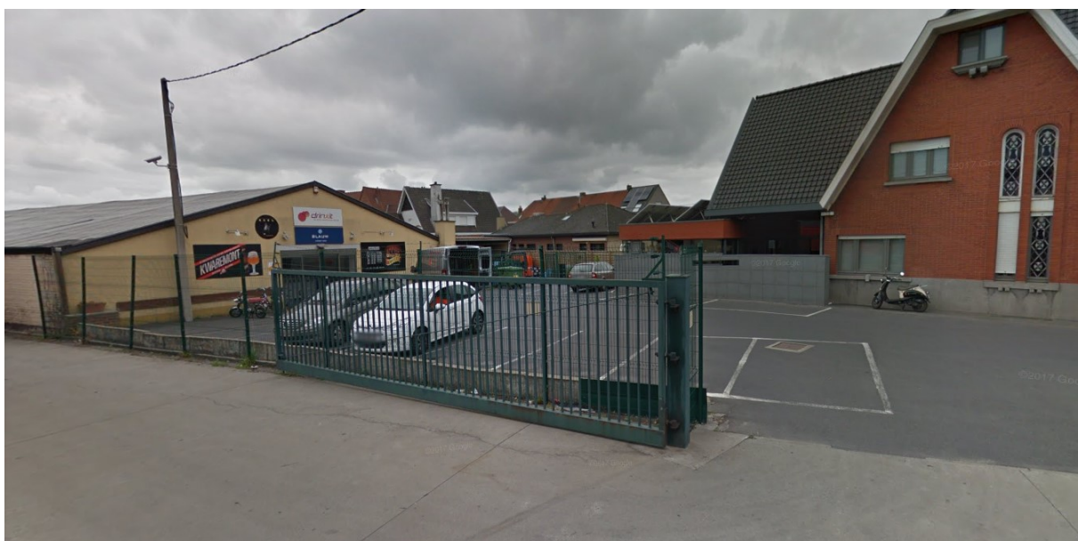
Figuur 3 Zicht op het westelijke deel van het plangebied met rechts de woning en links de drankcentrale. (bron: google)
