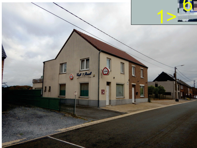
1: zuidwesthoek aan de Klaverstraat
