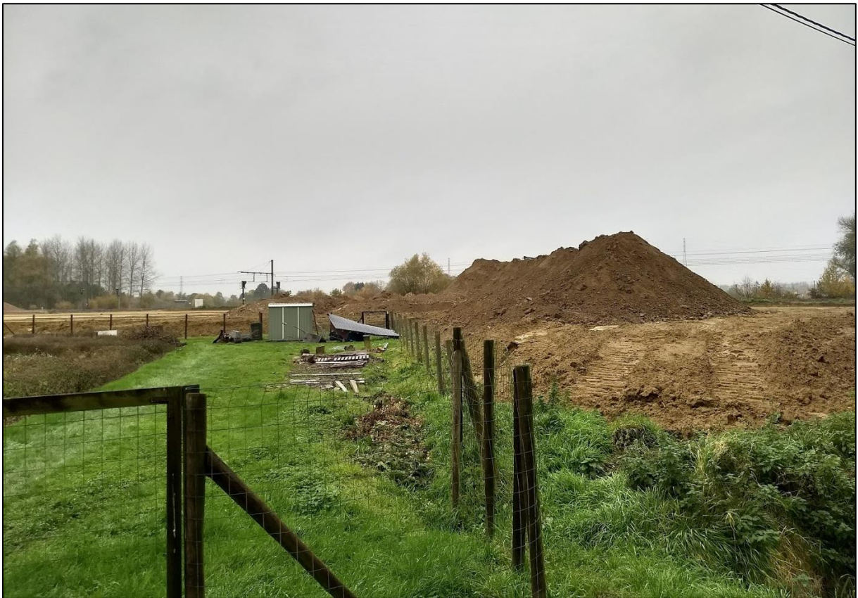
Afb. 29: Detailfoto van de ophoging op perceel 337A (Foto genomen door initiatiefnemer vanaf de Spoorstaat met zicht op oostelijke deel van het onderzoeksterrein).
