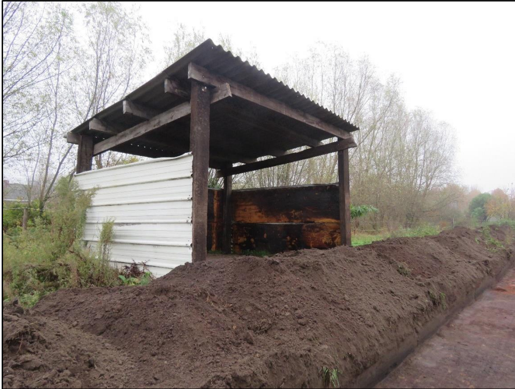
Figuur 2 Zicht op het stalletje in noordelijke gedeelte van het projectgebied.
