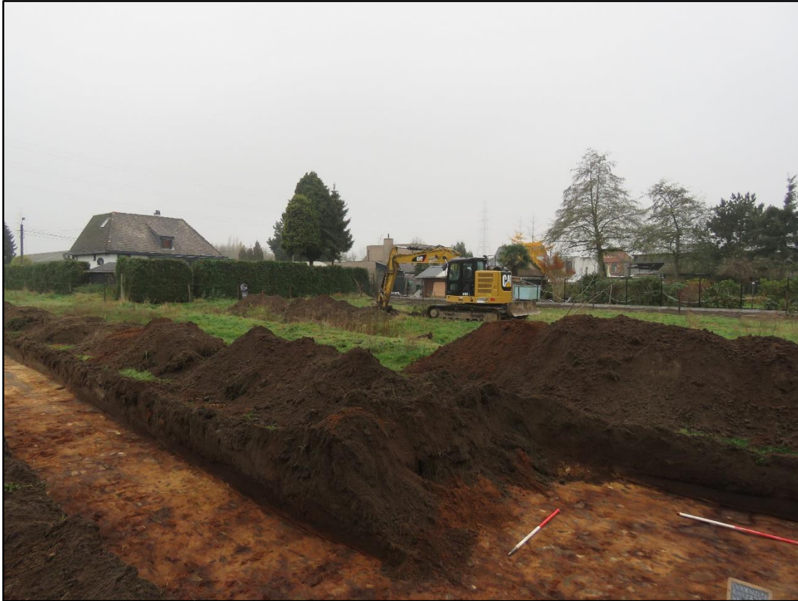
Figuur 8 Zicht op sleuf 2 met kijkvenster en de aanleg van sleuf 3.
