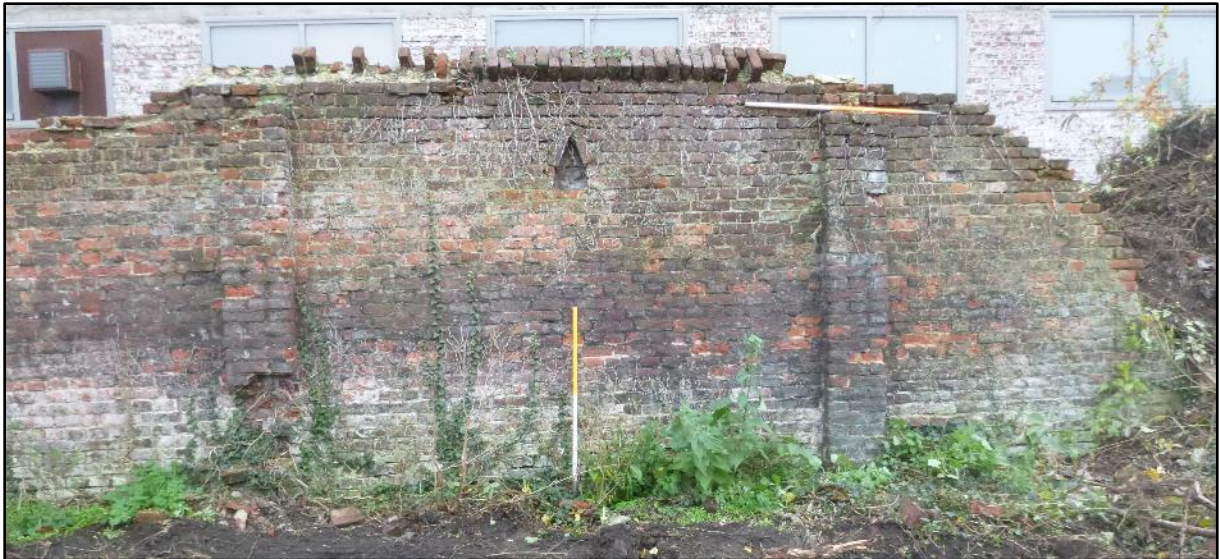
Figuur 62: Muurpartij in het zuidelijke deel van het onderzoeksgebied (ABO nv 2018)
