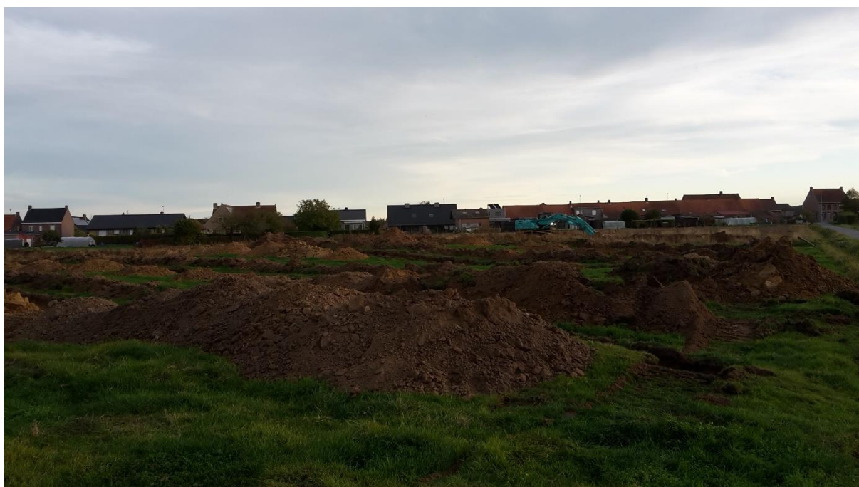
Figuur 36: Overzicht van de proefsleuven (zicht naar zuidoosten).
