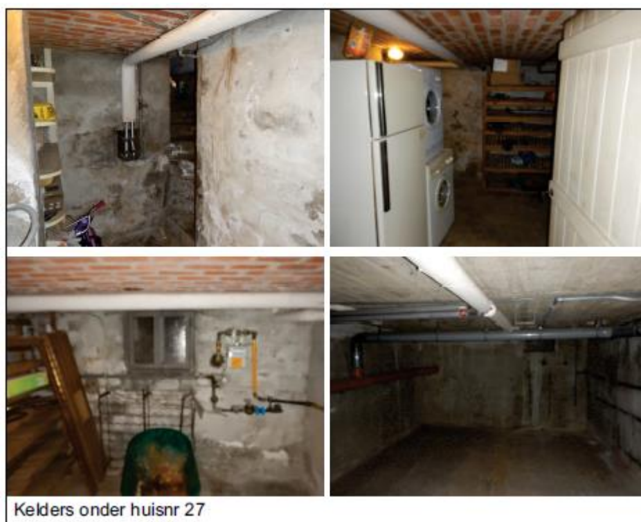
Fig. 13: de kelder onder Mgr. Koningsstraat 27 2
