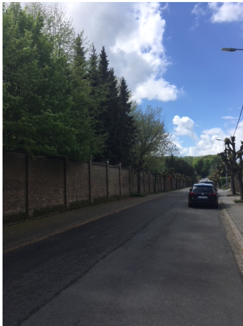
Figuur 13 : ommuring in de Sint-Wivinadreef ( bron : Bouwaanvraag, TV V+/CENTRAL/Bollinger + Grohmann, 2018)
