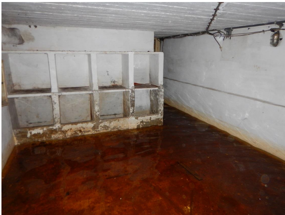
Figuur 4: Foto van een deel van de onderkelderde ruimte onder het woonhuis
