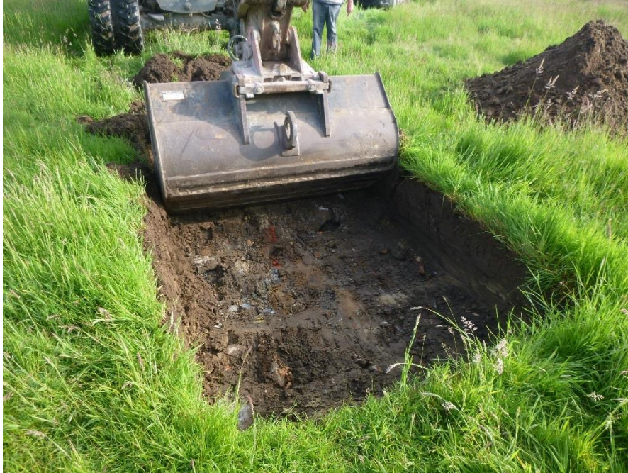
Figuur 1: Aanleg van een profielput.
