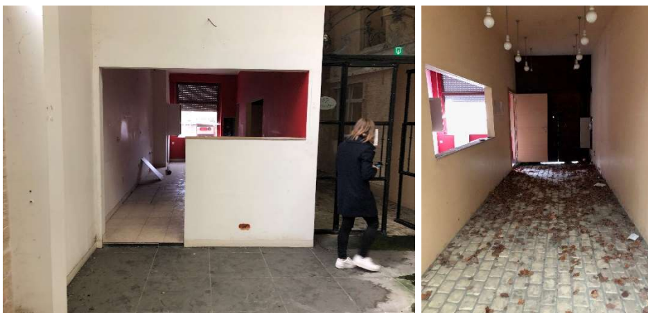
Figuur 3b. Zicht op het voorste gedeelte (straatkant) van huisnummers 7 en 9 (boven), en de binnenkant langs de straatkant van huisnummer 9 (onder).
