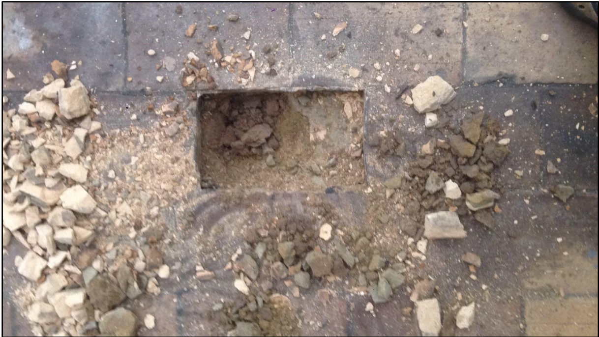
Figuur 4 Zicht op de opbouw van de interne baksteenvloeren, gefundeerd op een dun zavelaagje met daaronder de originele bodem.
