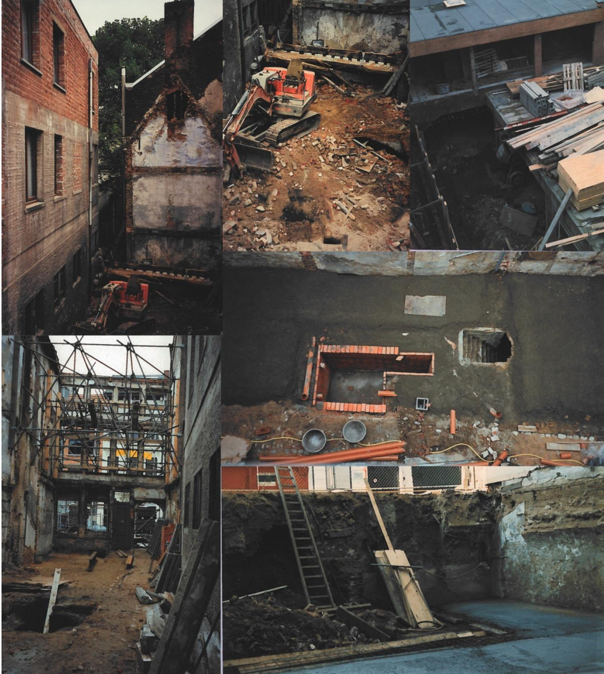
Fig. 1.4. Antwerpen-Keizerstraat 63-69. Fotocollage van de verbouwingen uit 1985 en 1993. Boven v.l.n.r.: Keizerstraat 69 na sloop (1993); Vloer van nr. 69 met zicht op de kelder, waar de vloer deels ingestort is; Keizerstraat 63, achterhuis situatie tijdens de bouw in 1985. Midden rechts: Nieuw gemetselde beerput onder nr. 69 naast de oude kelder (1993). Onder v.l.n.r.: Keizerstraat 69 na sloop met keldergat (1993); Uitgebroken kelder van Keizerstraat 65 met nieuw gestorte betonvloer en de aanzet van de uitgebroken gewelven op de zij- en achtermuren.
