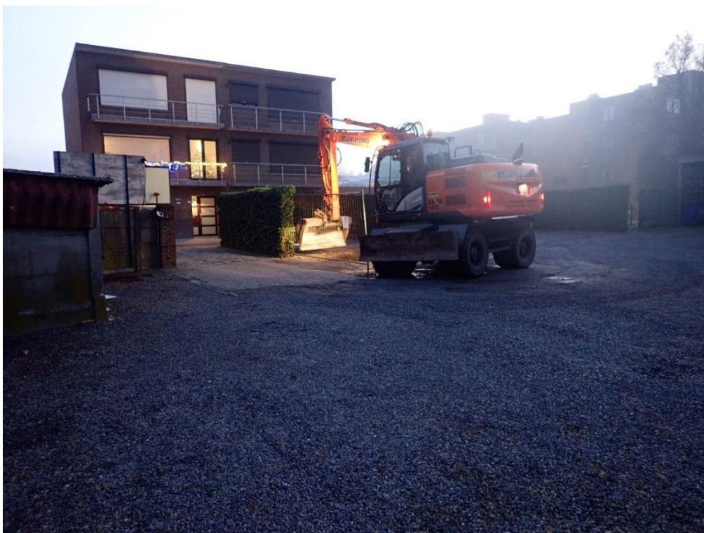
Figuur 11: Zicht op het plangebied, voor aanvang van het proefsleuvenonderzoek: detail 5 (© J. Verrijckt Bvba)
