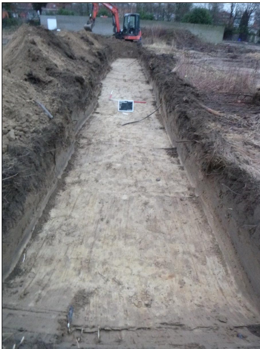
Figuur 45: Bijkomende proefsleuf Werkput 5 (©BAAC)
