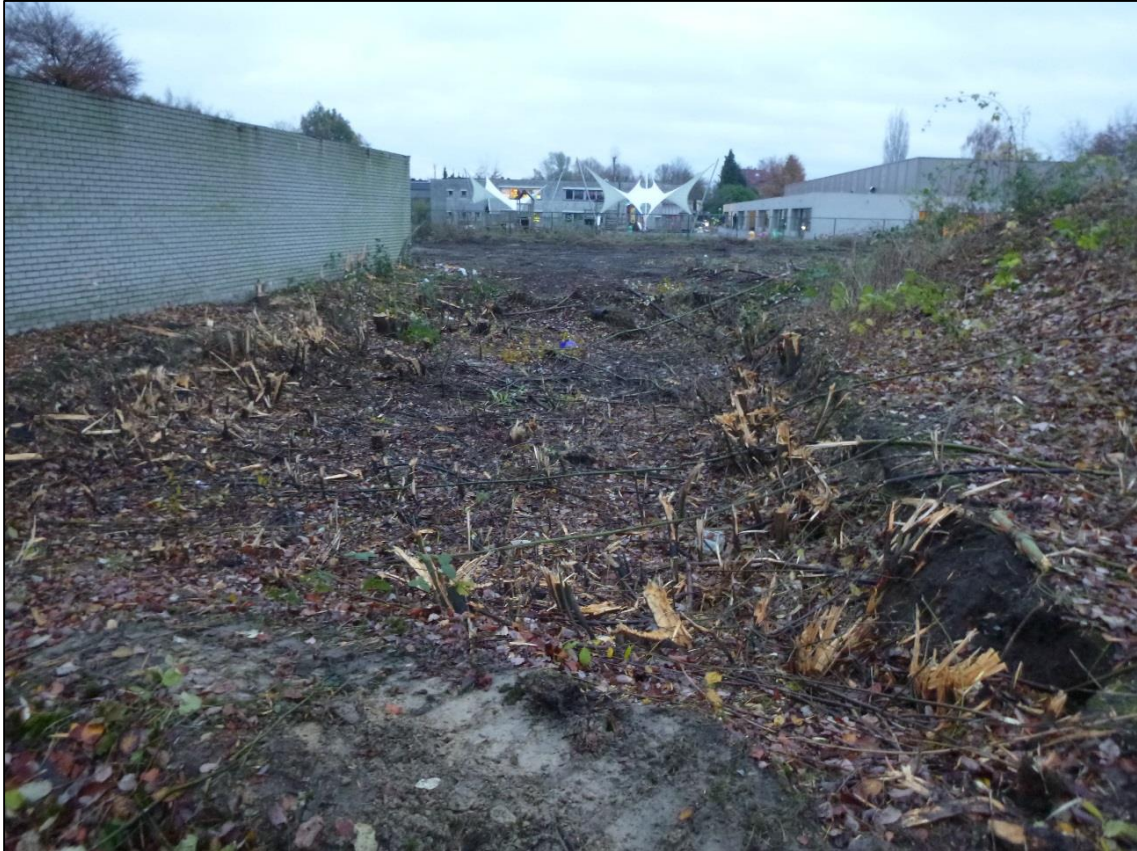
Figuur 14: Afgraving en versterking van het terrein in het noordoosten van perceel 133d5.
