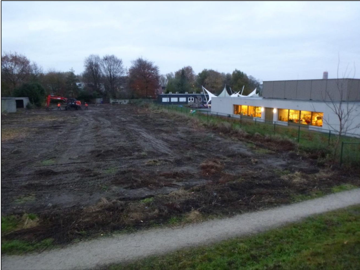
Figuur 5: Het onderzoeksgebied vanop de Auwegemvaart in zuidoostelijke richting (@BAAC)
