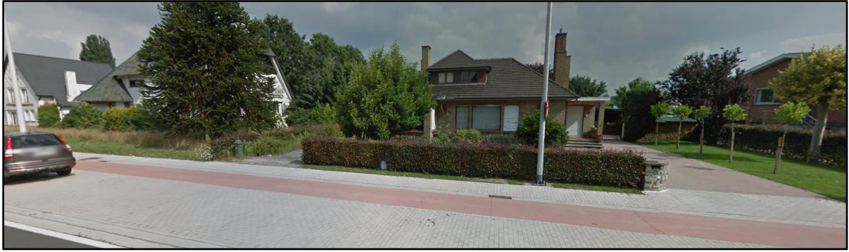
Figuur 2 Zicht op het plangebied, naar het noorden gezien, vanaf de Guido Gezellelaan (bron: https://www.google.com/maps ).
