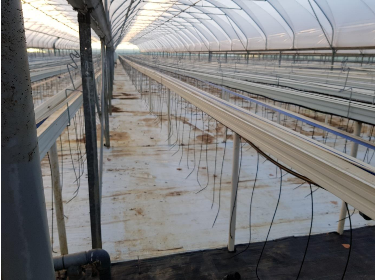
Figuur 2. Zicht op uitvoering tunnebogen, bovenaan dikke palen die geboord worden
