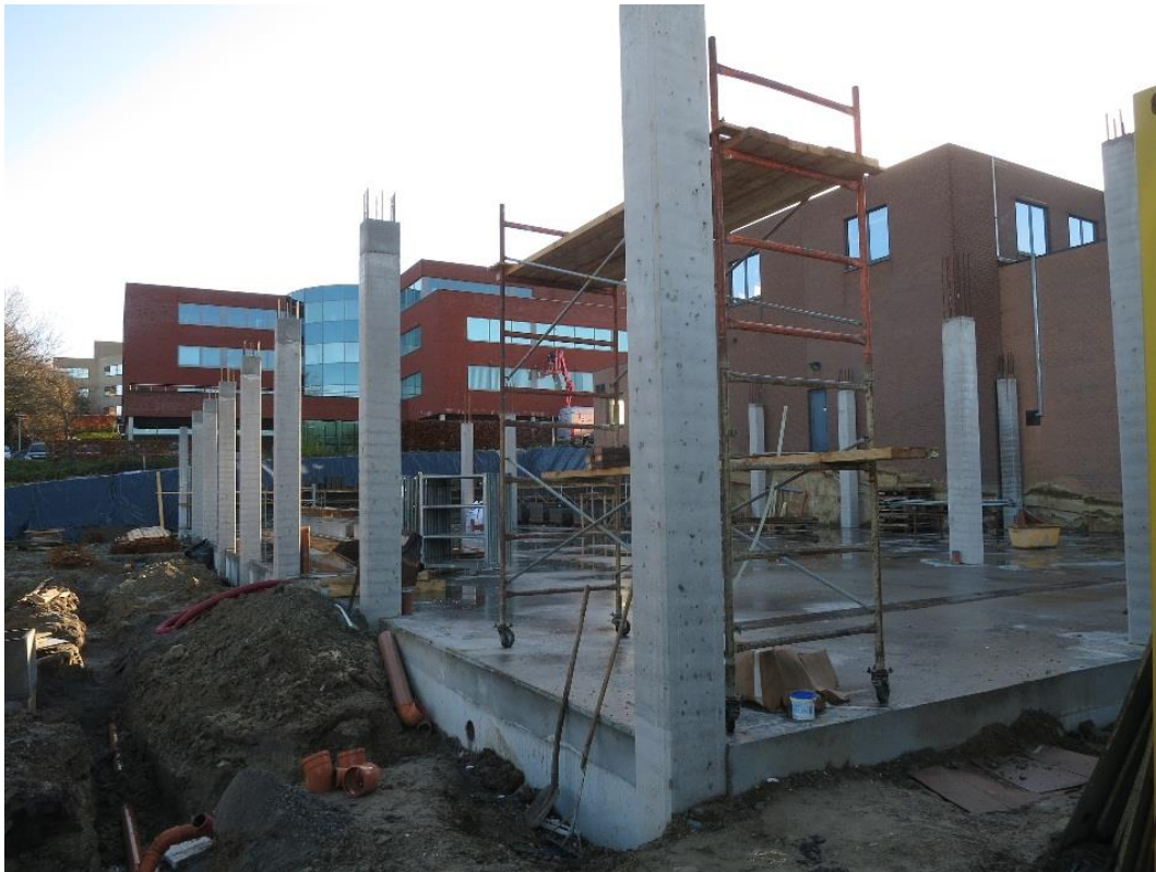
Figuur 6: Zicht op de reeds gerealiseerde nieuwbouw, waarbij de verstoorde grondwerken al gebeurd zijn. De uitgravingen, paalfunderingen, betonplaat, kolommen en aangelegde nutsleidingen zijn zichtbaar (Foto initiatiefnemer).
