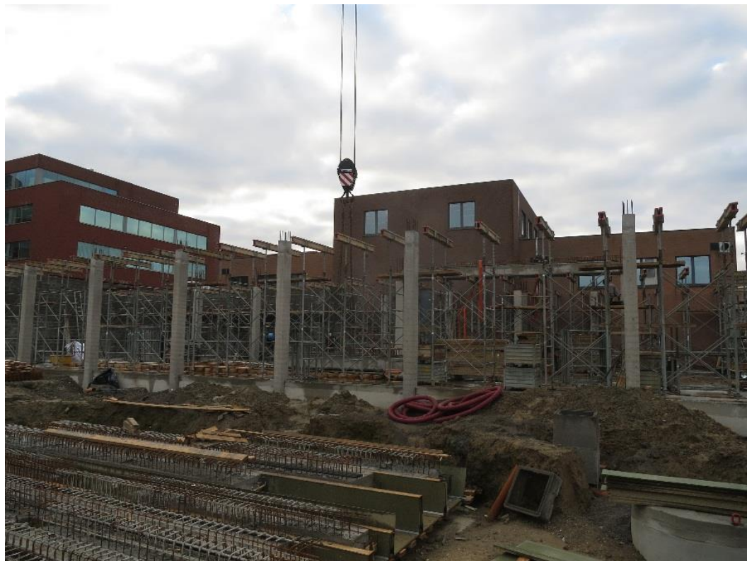
Figuur 7: Zicht op de reeds gerealiseerde nieuwbouw, waarbij de verstoorde grondwerken al gebeurd zijn. De uitgravingen, paalfunderingen, betonplaat, kolommen en aangelegde nutsleidingen zijn zichtbaar (Foto initiatiefnemer).
