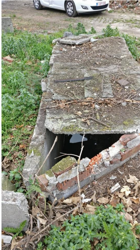
Figuur 62: Aanwezigheid van ondergrondse cisterne (ABO nv 2018). Foto is genomen op 20-11-2018.
