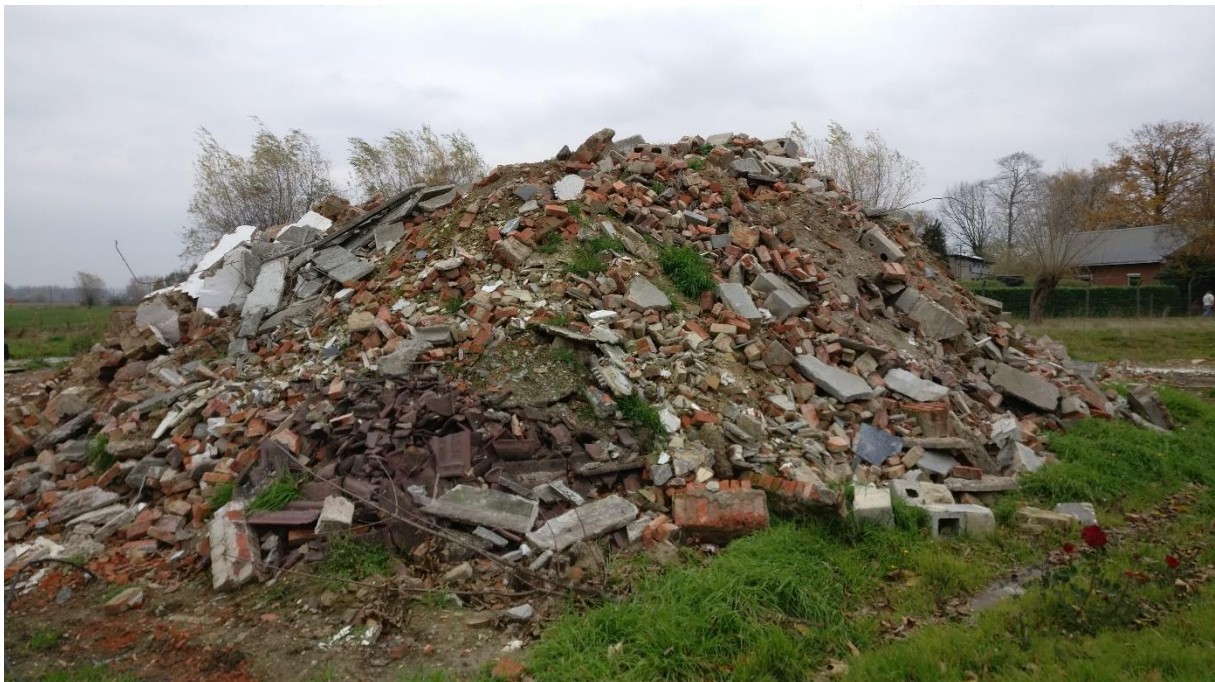
Figuur 63: Puinlaag ter hoogte van boring nr. 7 (ABO nv 2018). Foto is genomen op 20-11-2018.
