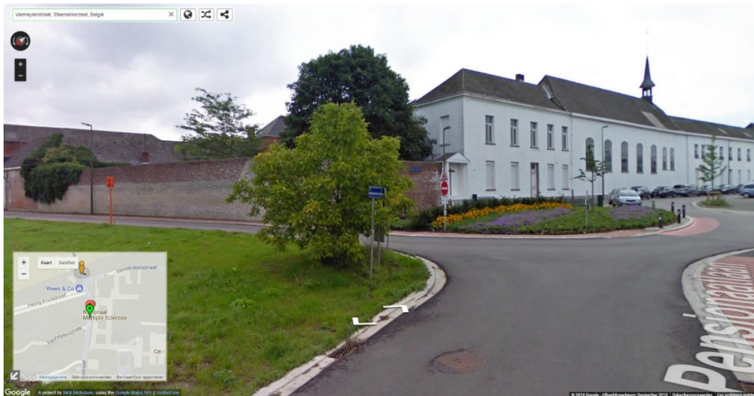
Figuur 8: Zicht op het klooster vanuit de Pensionaatlaan. (Bron: Google Maps, september 2010).
