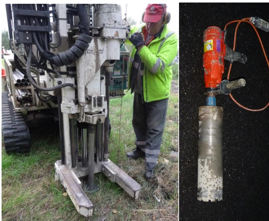
Figuur 24: Geoprobe in werking (links) en kernboor (rechts).
