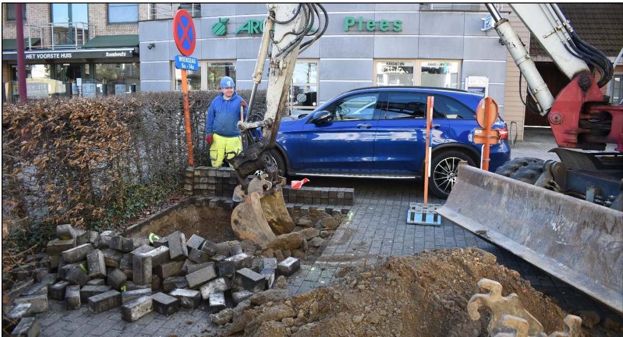
Afb. 40: De aanleg van PP3 ter hoogte van de Harmoniestraat (Bron: ARON bv, dd. 12/3/2020, 2020C224)
