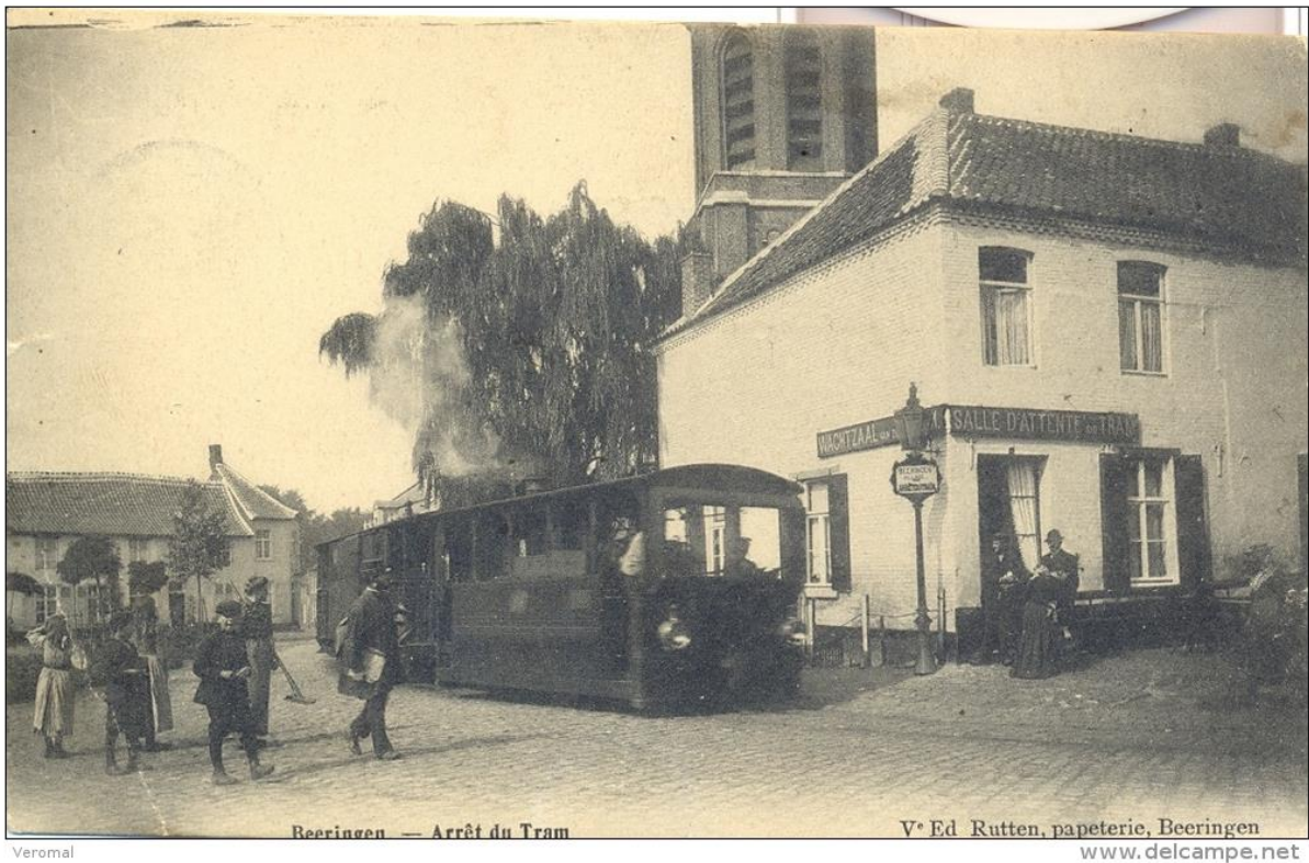
Afb. 27: Zicht op het marktplein met achteraan de kerk Sint-Pieters-Banden. De bebouwing ten zuiden de kerk wordt ingenomen door een wachtzaal voor de tram. Op basis van de foto en het tracé kan vermoed worden dat de lijn langs de huidige Koerselsesteenweg verder liep. Een (Bron: delcampe.be).
