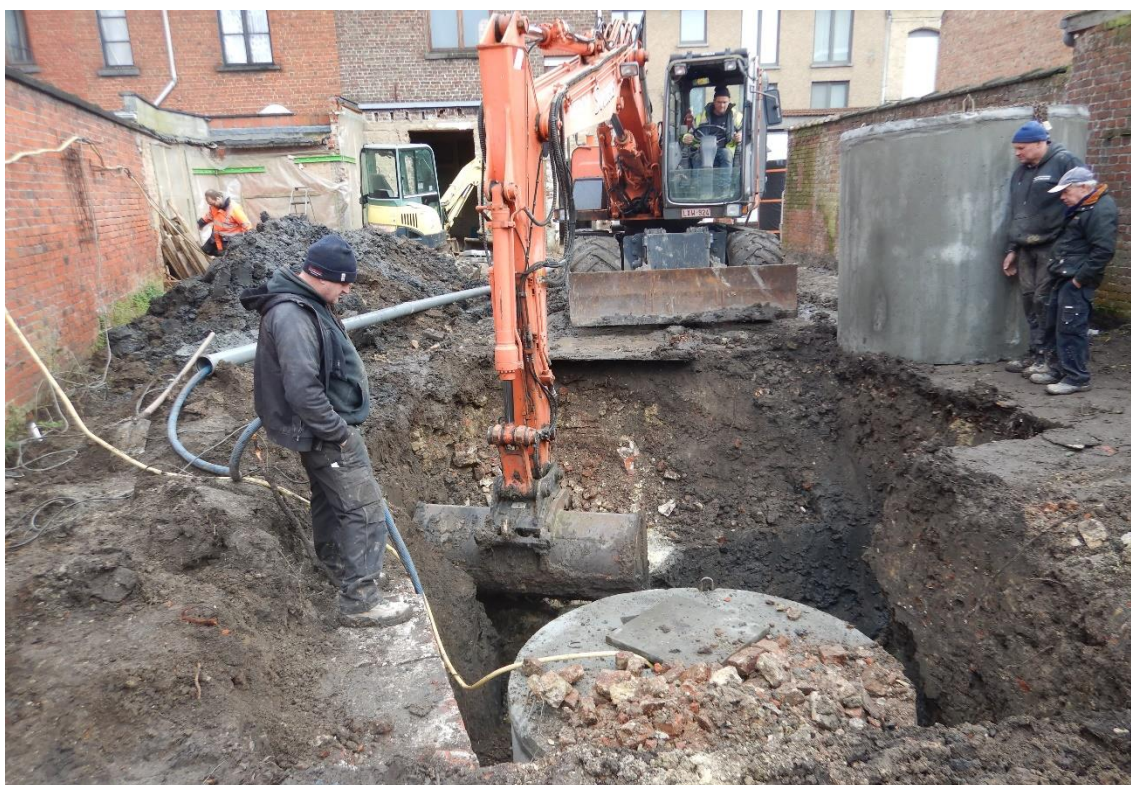
Figuur 9: Zicht op het uitgraven van een bestaande waterput binnen zone 2.
