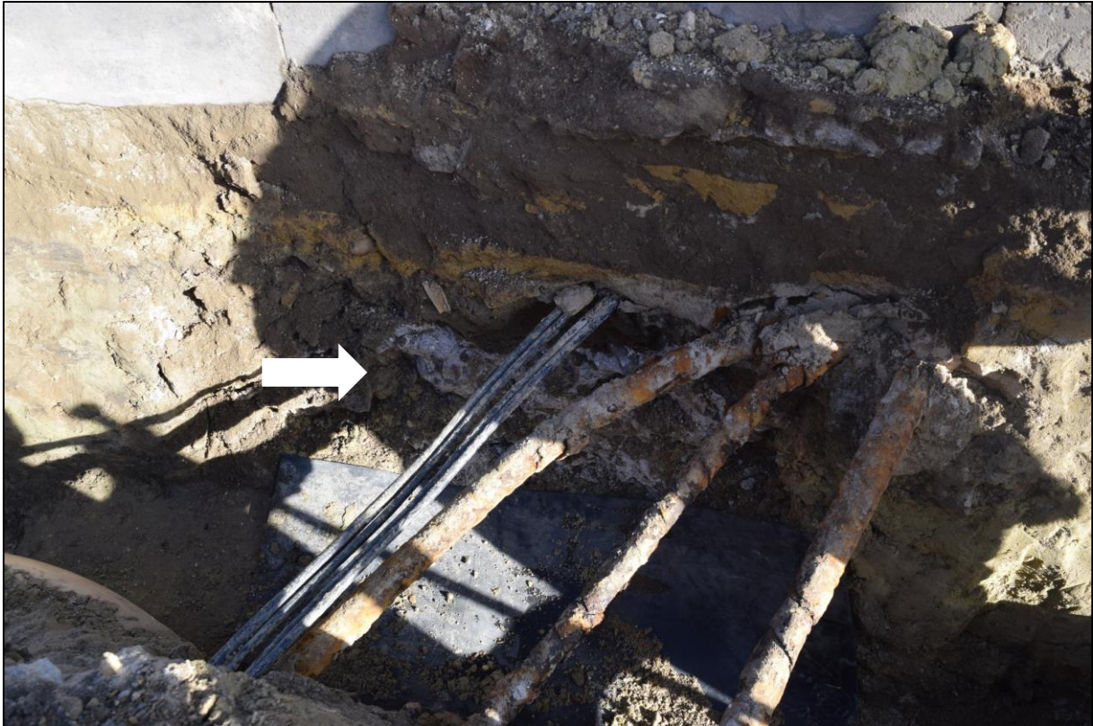
Afb. 34: Interventie 7: silexstenen gevat in mortel en in het verleden reeds doorbroken door oude nutsleidingen.
