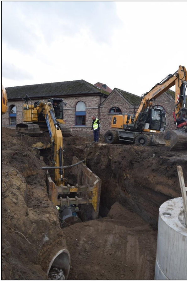
Afb. 7 en 8: Aanleg van een nieuw segment van de riolering met behulp van de 'sleuvenbak' en de soms moeilijk te registreren profielen.
