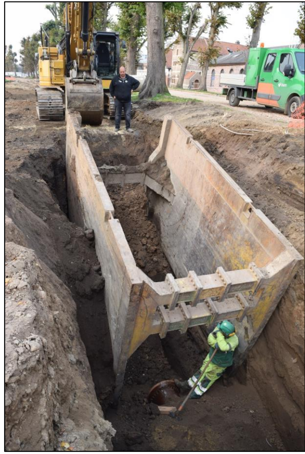
Afb. 7 en 8: Aanleg van een nieuw segment van de riolering met behulp van de 'sleuvenbak' en de soms moeilijk te registreren profielen.
