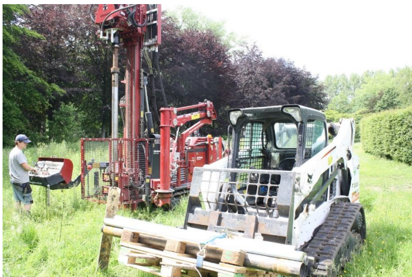
Figuur 10: Fotografische opname van de uitgevoerde mechanische boringen.
