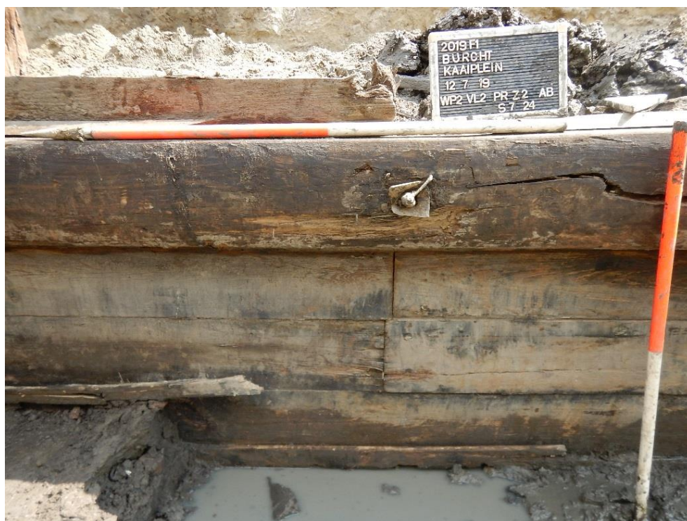
Figuur 146: Detail langs binnenzijde van de beschoeiing (S24) uit de recentste grote herstelfase
