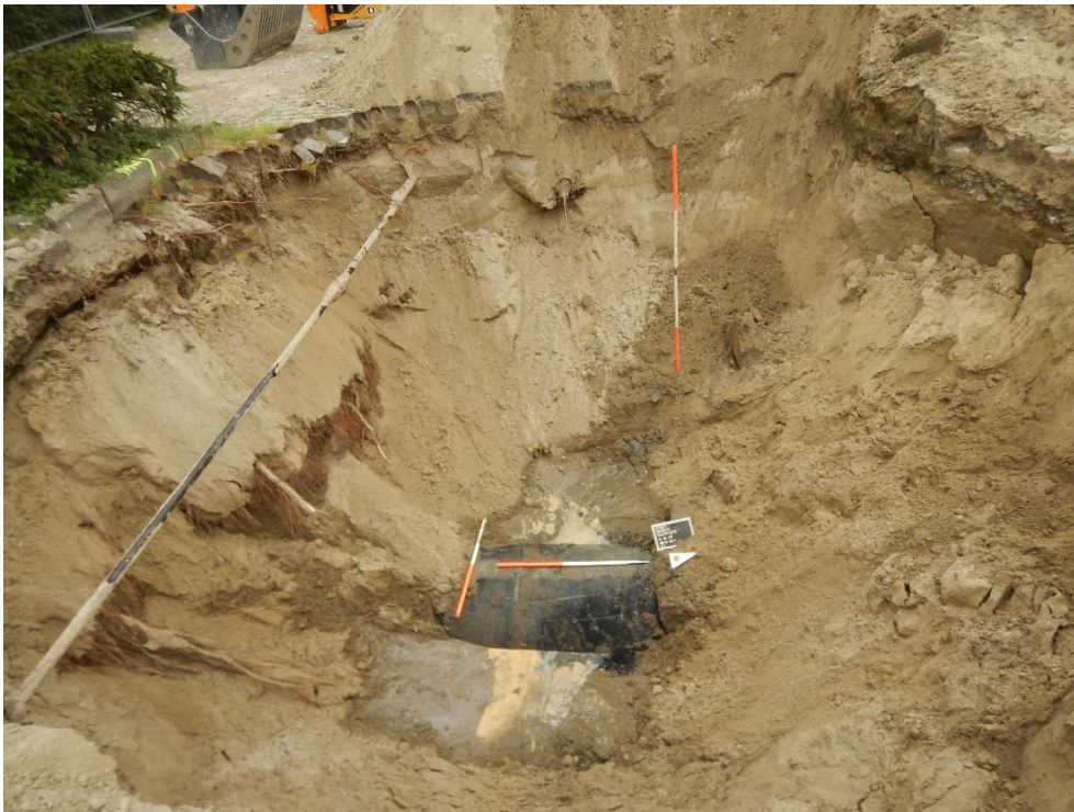
Figuur 22: Werkput 0 met rioleringsbuis in opgespoten zand
