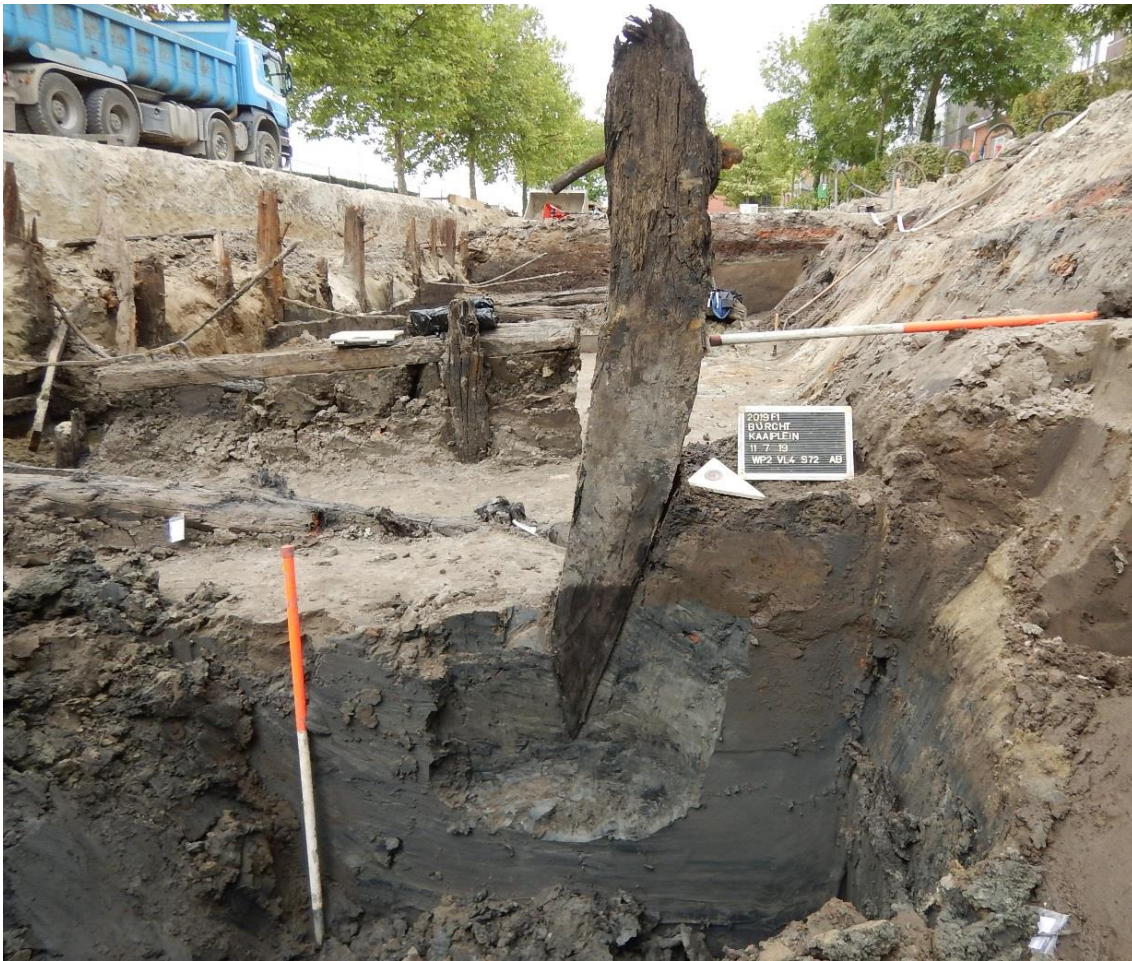
Figuur 166: Coupe langs houten paal (S72) voor bevestiging van trekanker
