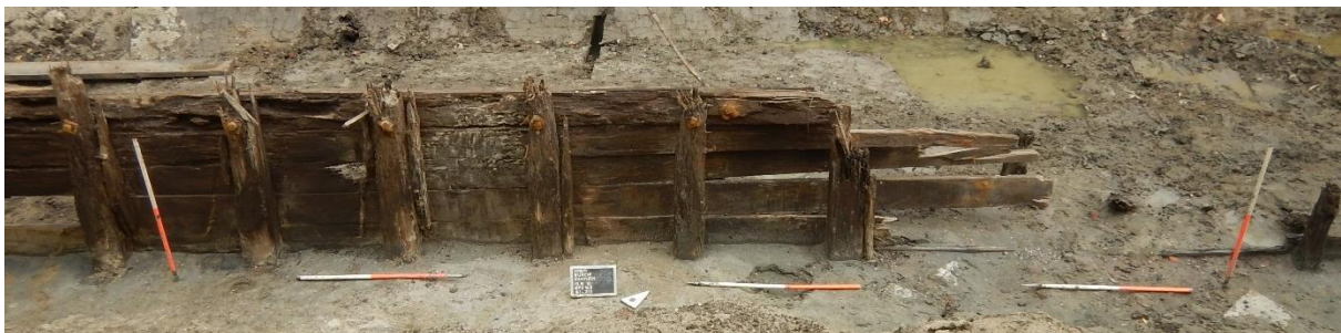
Figuur 148: buitenzijde van de beschoeiing (S24) uit de recentste grote herstelfase
