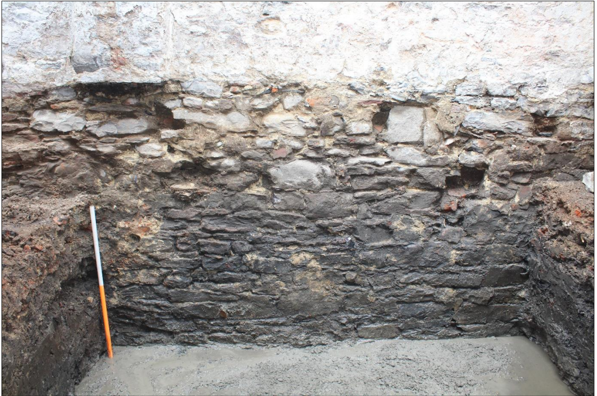
Figuur 131. Muur 2, ter hoogte van de liftkoker. De bovenkant van het profiel links correspondeert met de max. uitgraafdiepte.
