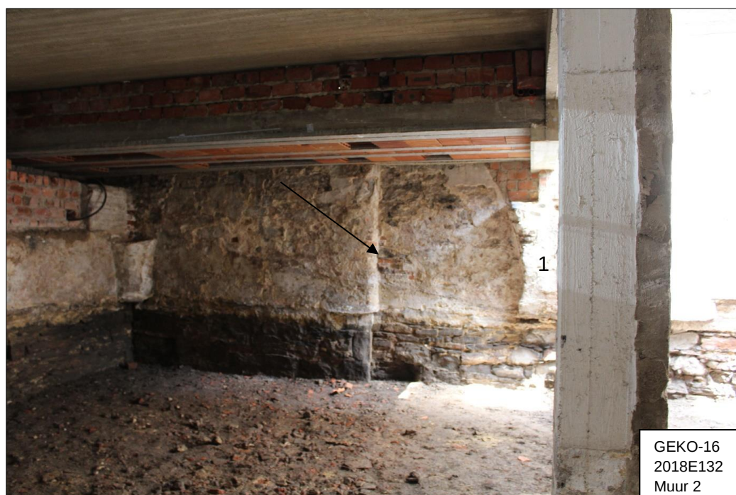
Figuur 28. Muur 2, noordzijde, met aanduiding van de inspringing van de ruimte. De hellingsgraad van de opgebroken helling is hier nog duidelijk zichtbaar.
