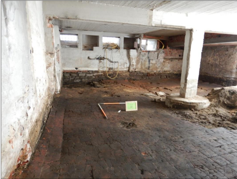
Figuur 54. Overzichtsfoto van S19 (richting Muur 1)
