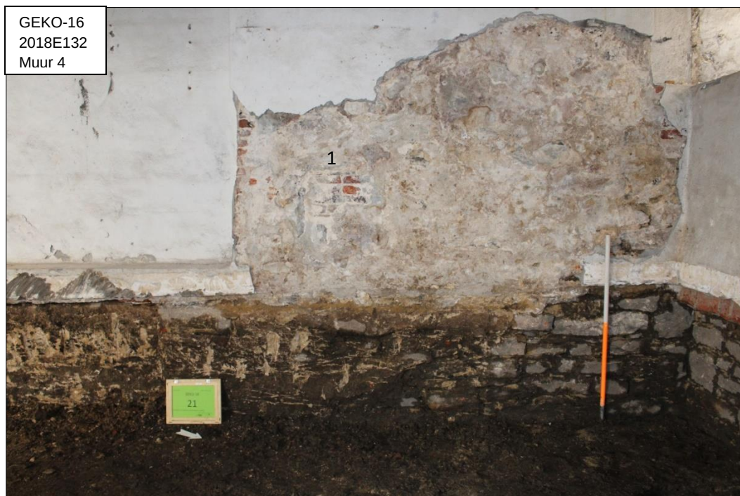
Figuur 33. Muur 4, noordzijde
