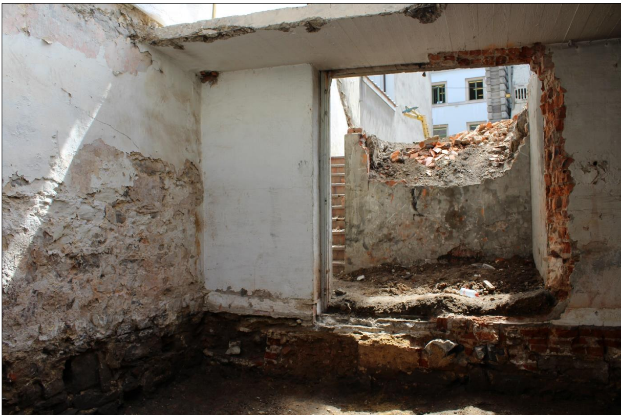
Figuur 133. Muur 3, oostzijde
