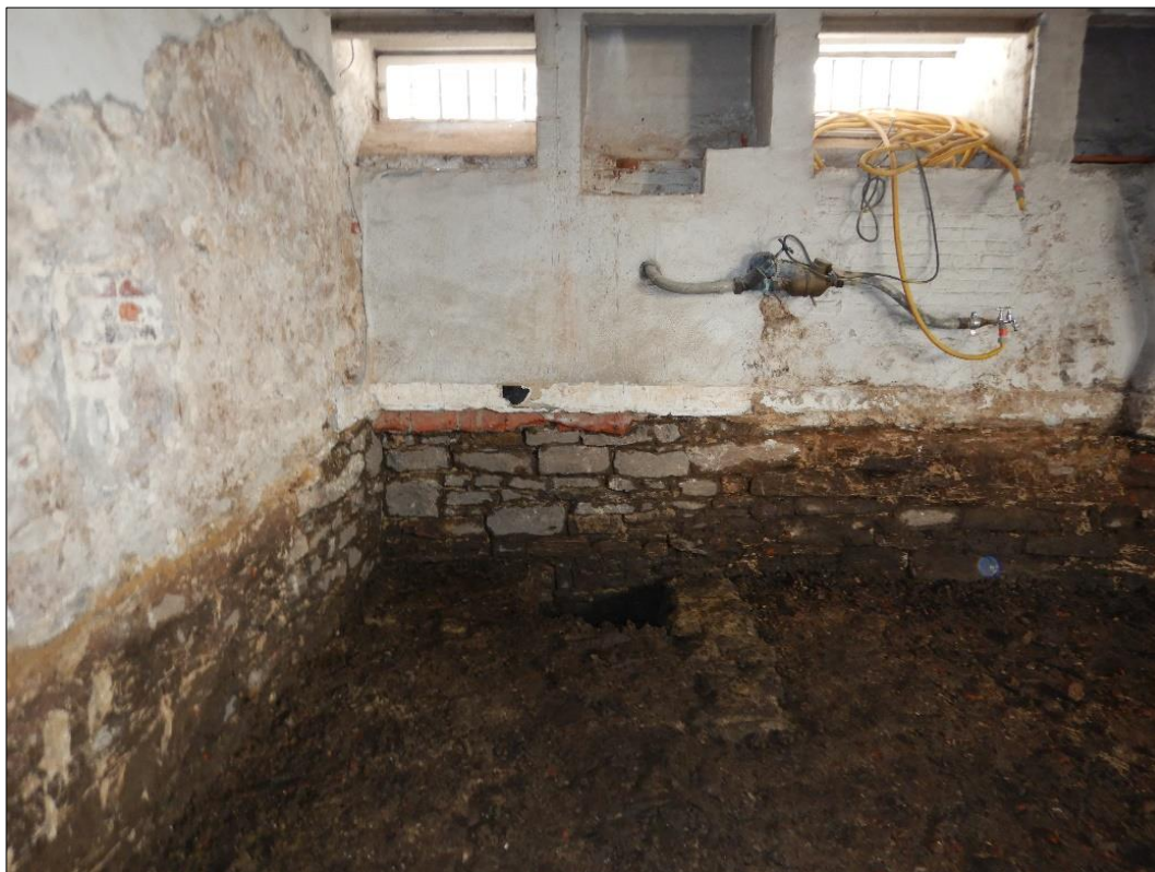
Figuur 125. Muur 1, westzijde (aansluiting op Muur 4)
