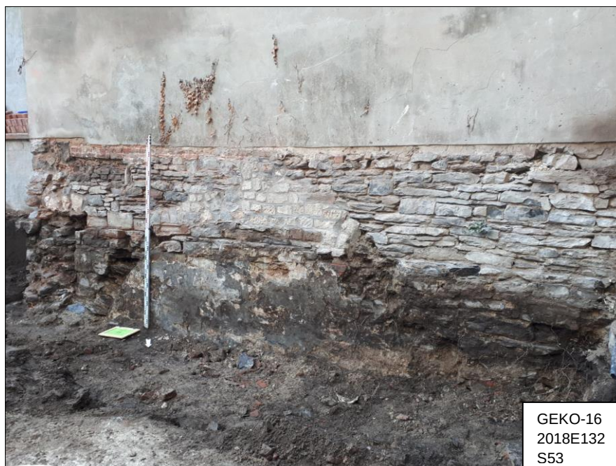
Figuur 88. S53. Overzichtsfoto-niveau 2 (na verdieping)
