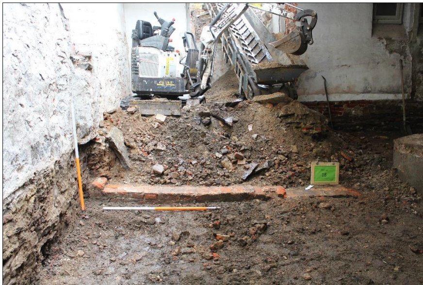
Figuur 66. Muur S24 in de oostelijke sector van WP1
