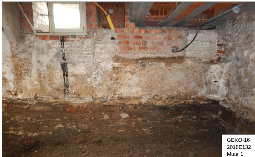
Figuur 25. Muur 1, oostzijde
