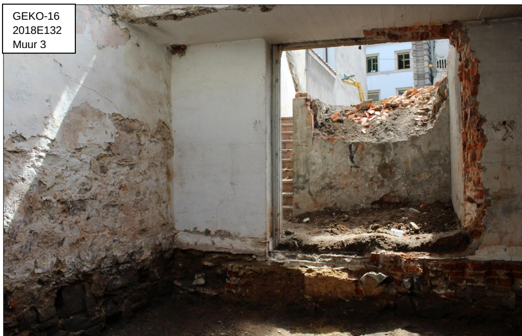
Figuur 30. Muur 3, oostzijde
