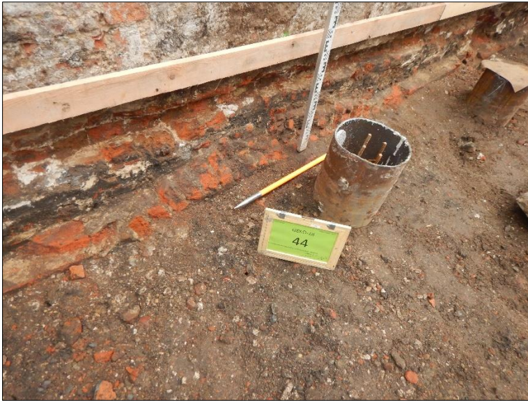
Figuur 94. Lokalisering S49 in de westelijke zijgevel ter hoogte van de Baaisteeg
