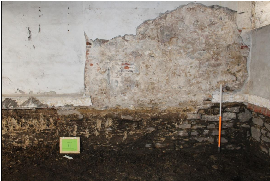
Figuur 134. Muur 4, noordzijde
