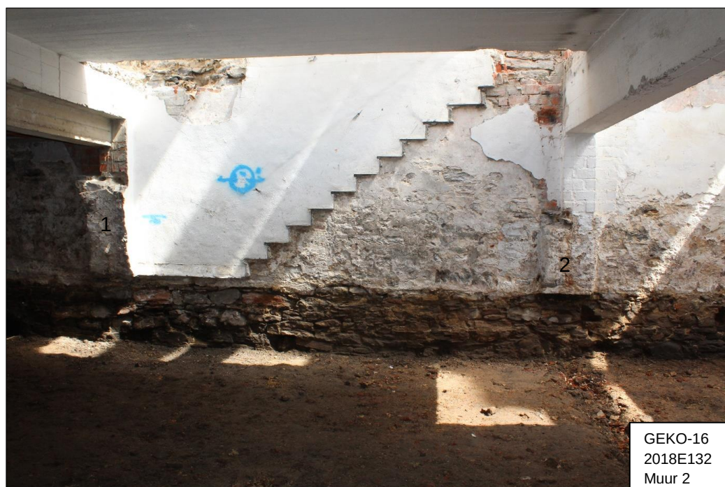
Figuur 27. Muur 2, centraal (ter hoogte van de uitgebroken trap)
