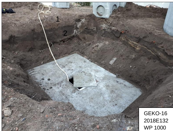
Figuur 92. Situatie na plaatsing van de citerne
