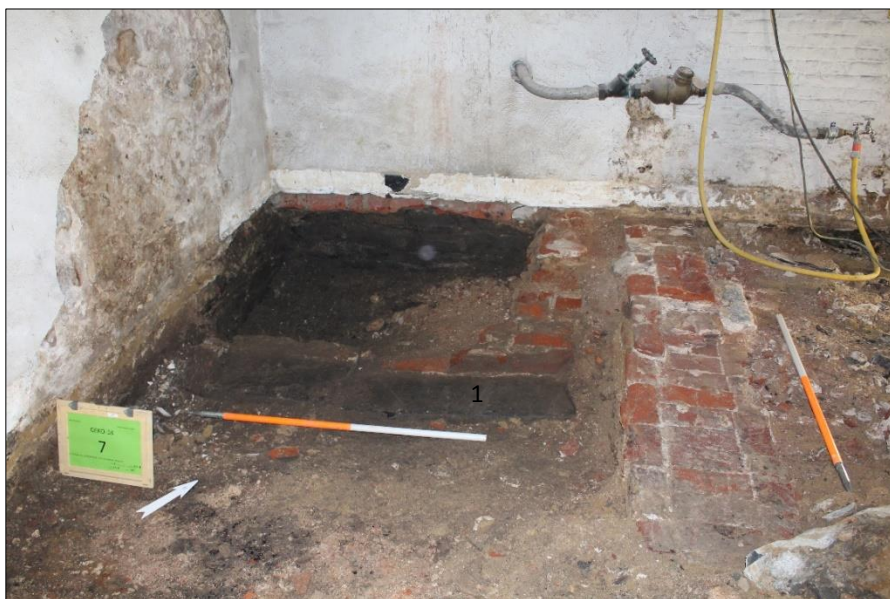
Figuur 72. Overzichtsfoto van de structuren in de hoek tussen Muur 1 en Muur 4
