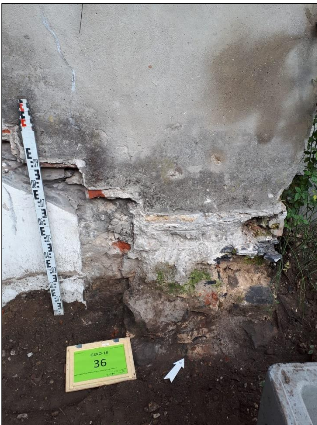
Figuur 91. S33. Aanzet zijmuur ter hoogte van de oostelijke zijgevel
