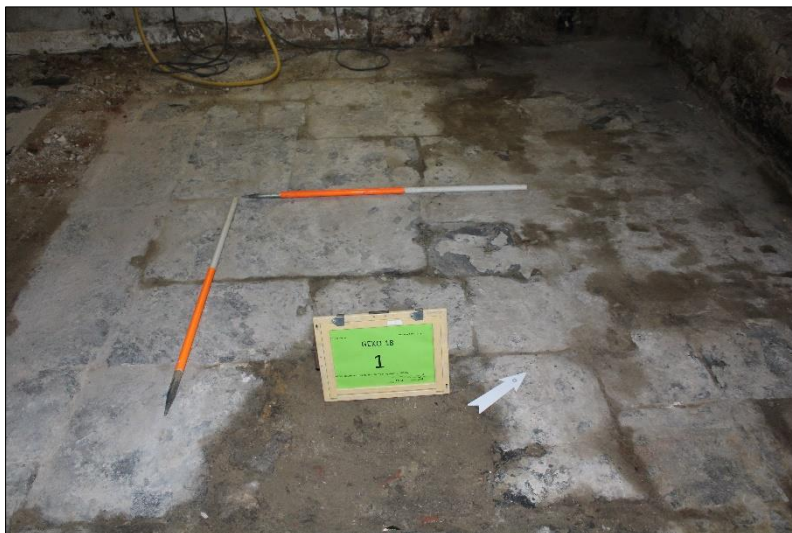
Figuur 48. Detailfoto van S1, net ten westen van S2: slijtagesporen zijn duidelijk zichtbaar.
