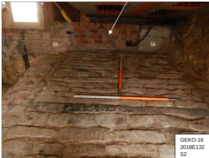
Figuur 42. Detailfoto van S2, met aanduiding van de gedichte opening in Muur 1
