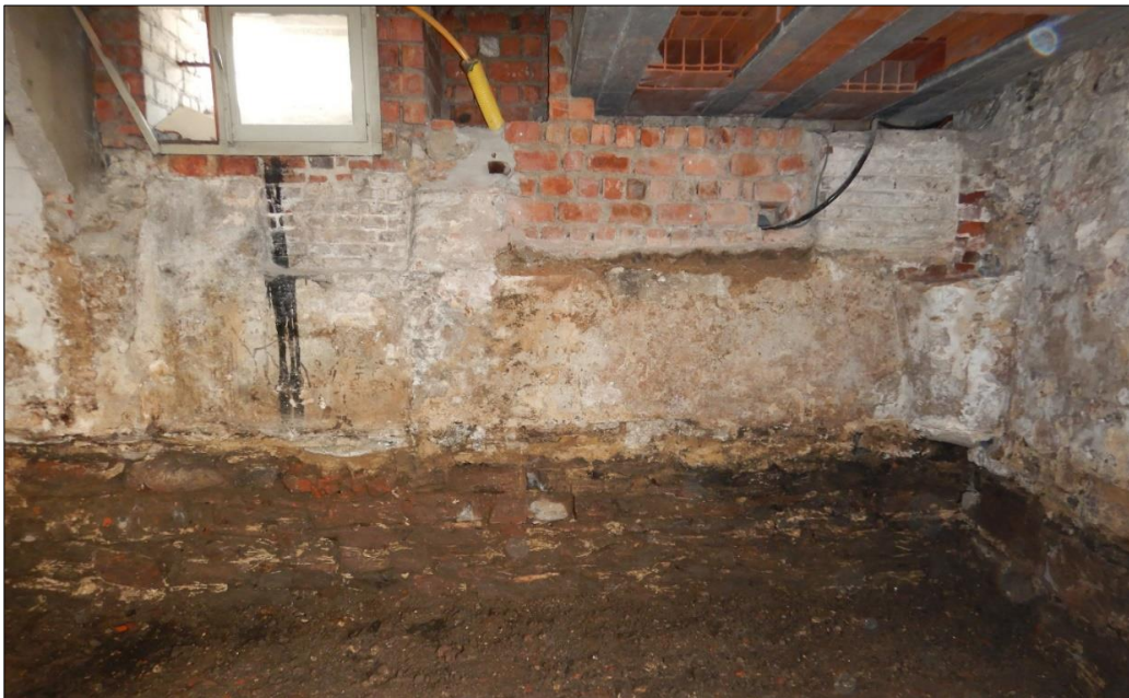
Figuur 122. Muur 1, oostzijde
