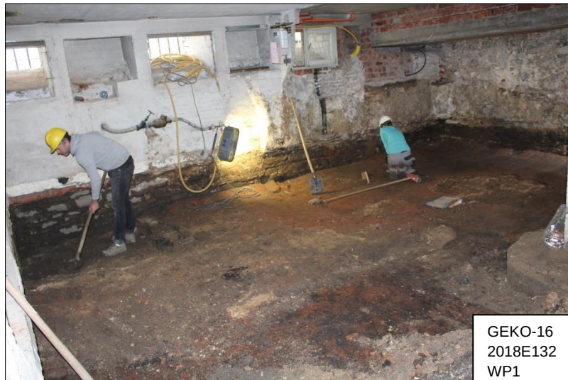
Figuur 18. WP1. Manuele opkuis van de vloerrestanten in functie van de registratie
