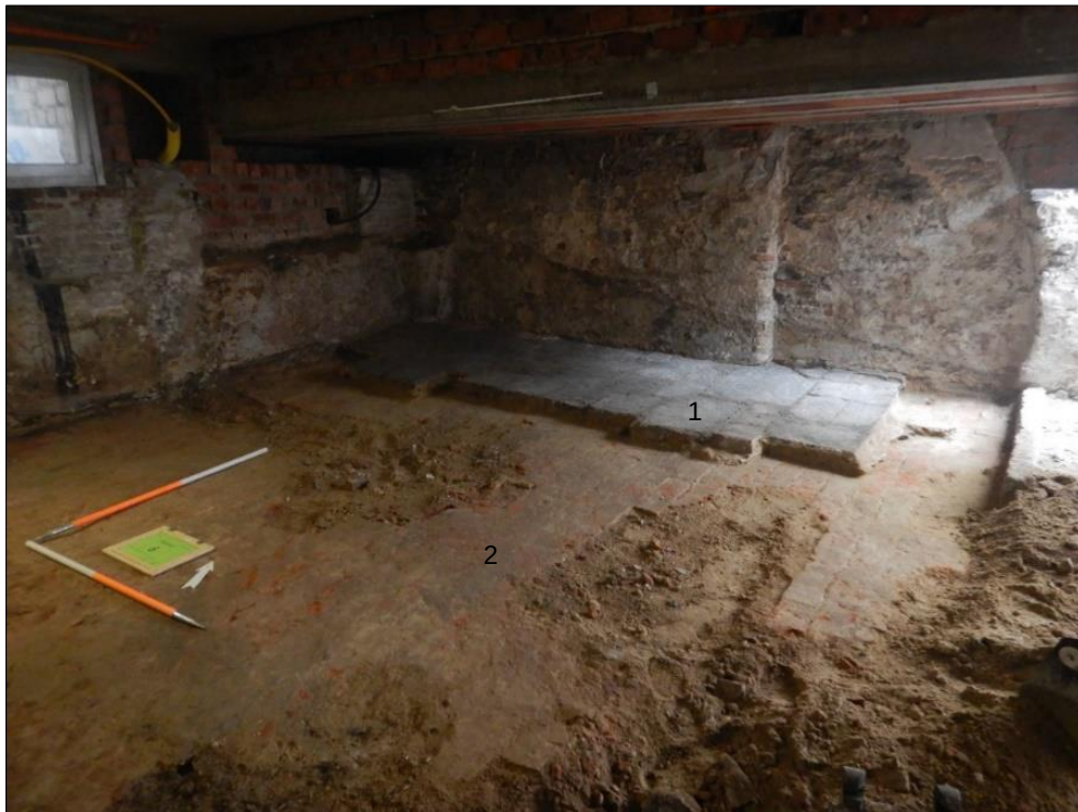
Figuur 51. Verband tussen natuurstenen vloer S12/S1 (1) en onderliggende bakstenen vloer S7 (2)
