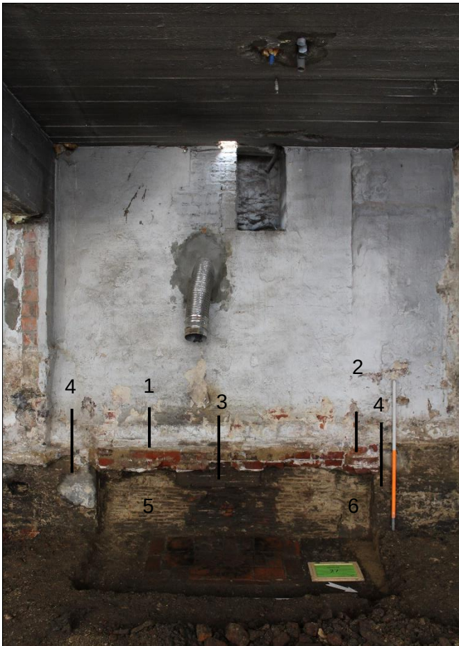
Figuur 71. Haardconstructie in Muur 4
