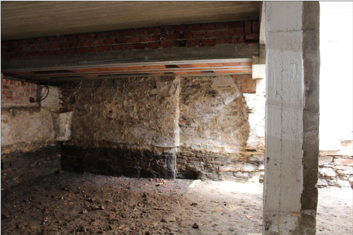
Figuur 129. Muur 2, noordzijde
