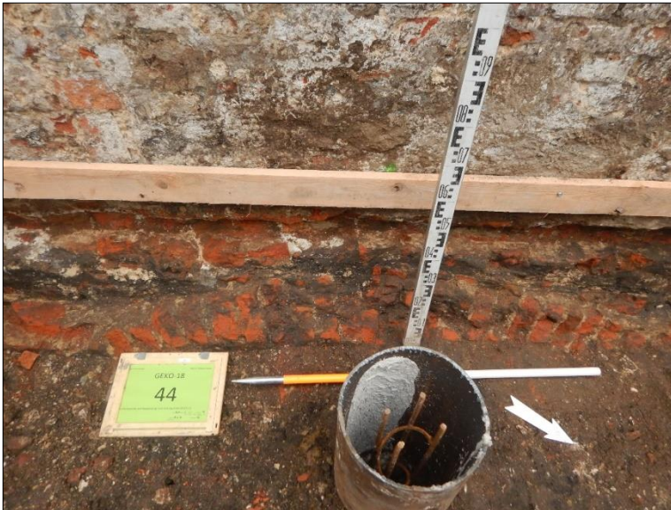
Figuur 95. Lokalisering S49 in de westelijke zijgevel ter hoogte van de Baaisteeg-detail
