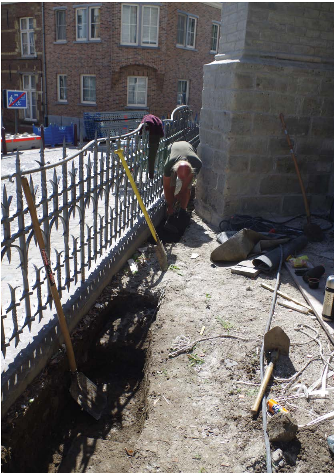
Fig. 5. Zicht op het uitgraven van werkput XXXIII.
