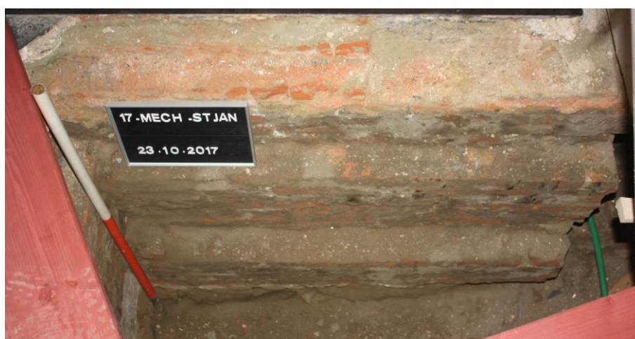
Figuur 8: Fundering 19de-eeuwse grafmonument uitgewerkt in verschillende trappen in de oostelijke collectorput. (© agentschap Onroerend Erfgoed: foto Erwin Meylemans)
