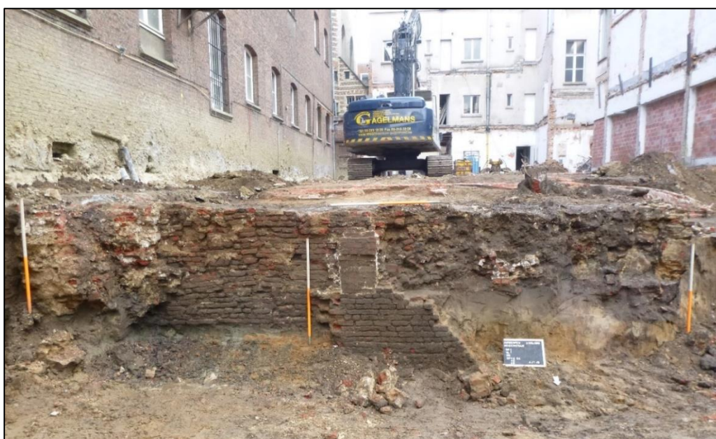
Figuur 85: Zicht op de noordelijke keldermuur spoor 46 met links de resten van een verstoorde beerput (Abo nv, 2020)
