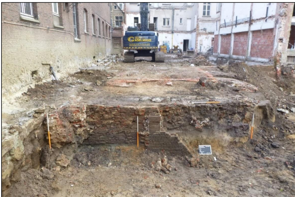
Figuur 84: Zicht op de kelders aan de noord- en oostzijde van het terrein (Abo nv, 2020)
