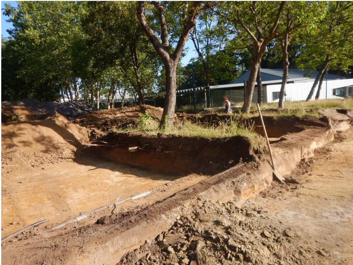
Figuur 4: Zicht op de aangelegde stroken tussen de nog aanwezige bomenrij. Centraal op de voorgrond zijn tevens in werking zijnde leidingen zichtbaar.
