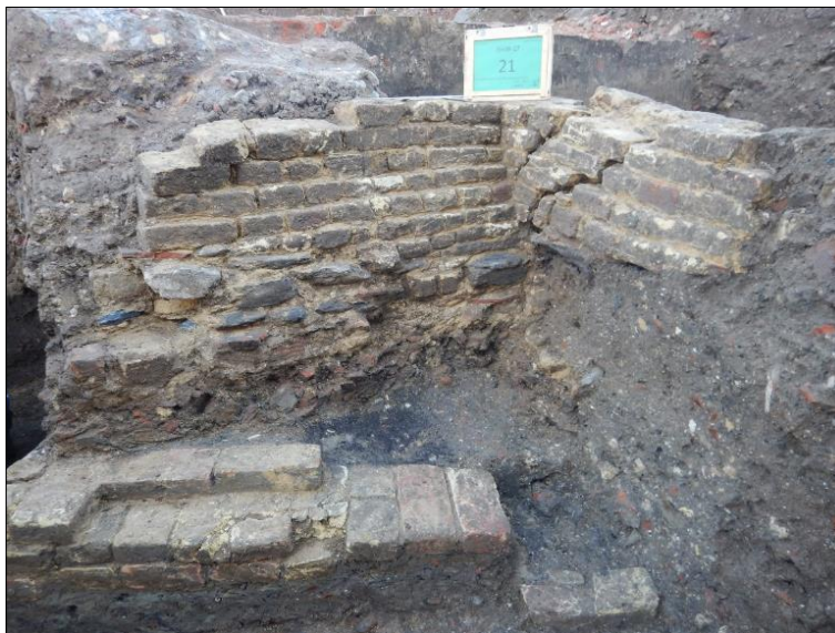
Figuur 97. Overzichtsfoto van S6, gefundeerd op Doornikse kalksteenblokken
