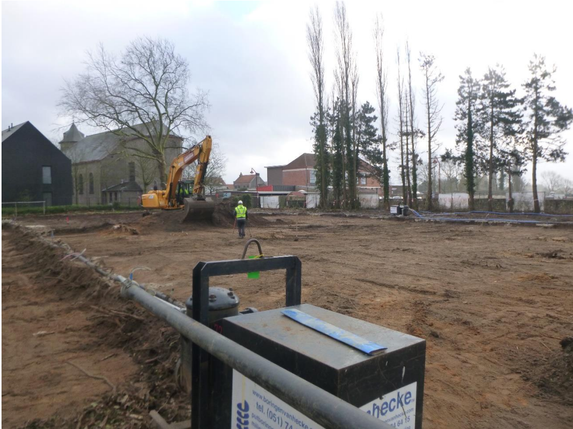
Figuur 2: Overzicht van het plangebied bij afgraving van het bovengrond onder begeleiding van munitie-expert, met zicht op de bemalingslijn die de put in twee deelt.
