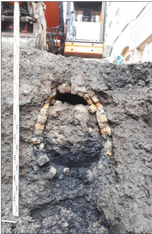
Figuur 38. Doorsnede bestaande riolering
