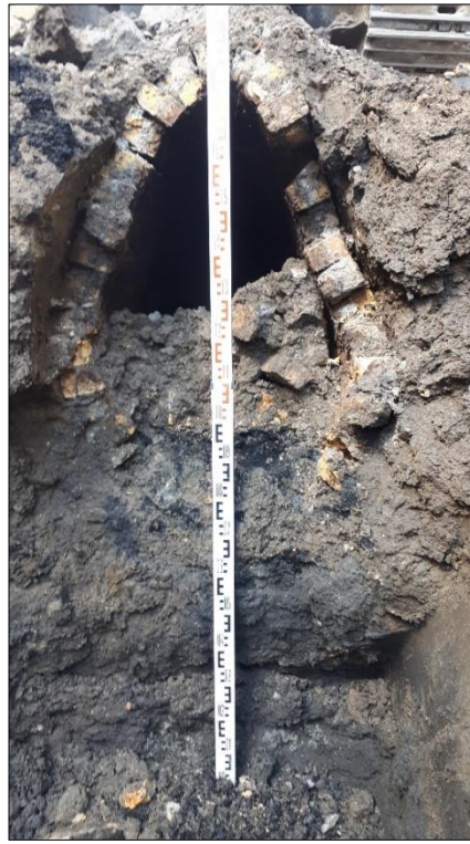
Figuur 37. Doorsnede bestaande riolering
